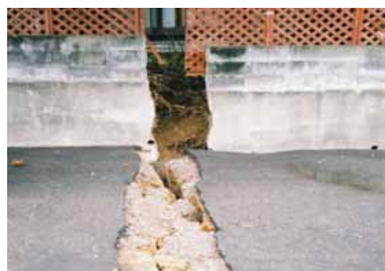
写真 8.3 宅地地盤の被害（地すべり、崖くずれ、地割れなどによる被害）
