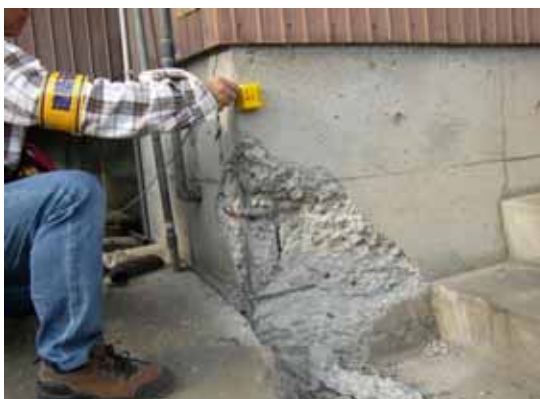
写真 8.38 戸建住宅の基礎の被害 (コーナー部の被害、増築部との接合部分における被害、ブロック基礎の移動・脱落など)
