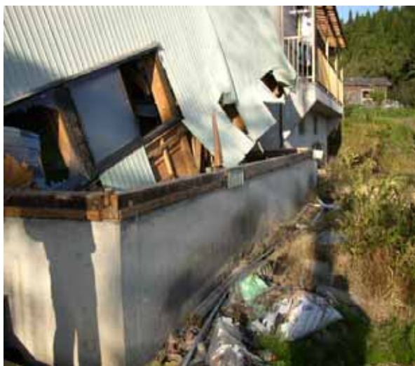
写真 8.37 戸建住宅の基礎と上部構造の被害 （基礎は無被害であるが上部構造が崩壊した例。基礎は鉄筋コンクリート造であることが多い）
