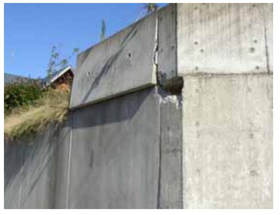
写真 8.30 宅地擁壁の被害
