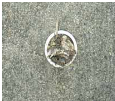
写真 8.32 擁壁の維持管理等の状況 (水抜き孔の孔詰まり、水抜き孔からの土砂流出)
