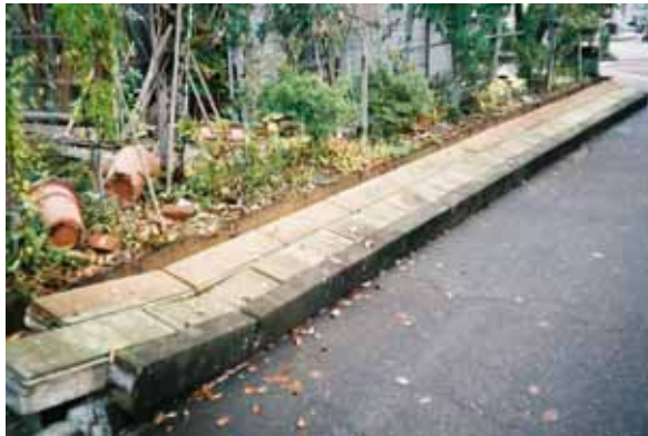
写真 8.33 宅地における低盛土（50～70cm）が崩壊することによる住宅の不同沈下や崩壊
