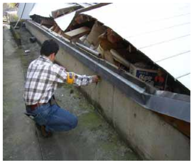
写真 8.37 戸建住宅の基礎と上部構造の被害 （基礎は無被害であるが上部構造が崩壊した例。基礎は鉄筋コンクリート造であることが多い）
