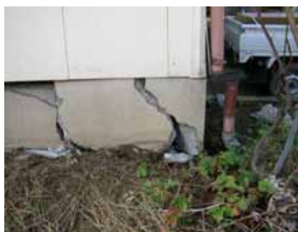
1/20 以上傾斜して大破した布基礎（柏崎市）
