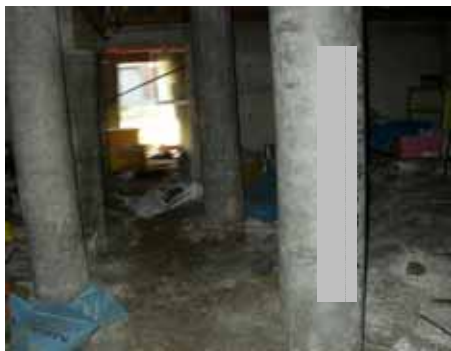
(c)床下の高い支柱・束（ろうそく基礎と呼ぶこともある） (d)無筋コンクリート 写真 8.1 被災地における古い住宅の基礎形式 （建物外周にブロック基礎を設置し、内部に高い束など設けていることが多い）
