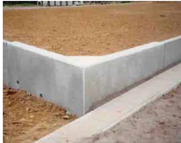
写真 8.42 コンクリート造擁壁におけるコーナー部の補強 (ハンチと壁厚の補強) 写真提供: (社) 全国宅地擁壁技術協会
