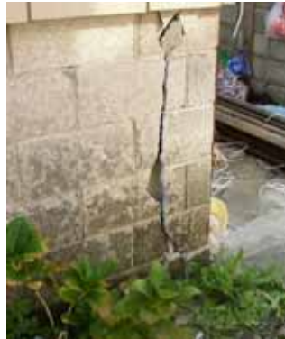
写真 8.35 戸建住宅の基礎の被害例 (ブロック基礎、石積み基礎、無筋コンクリート造基礎など)
