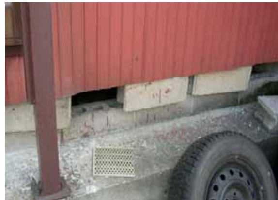
写真 8.38 戸建住宅の基礎の被害 (コーナー部の被害、増築部との接合部分における被害、ブロック基礎の移動・脱落など)
