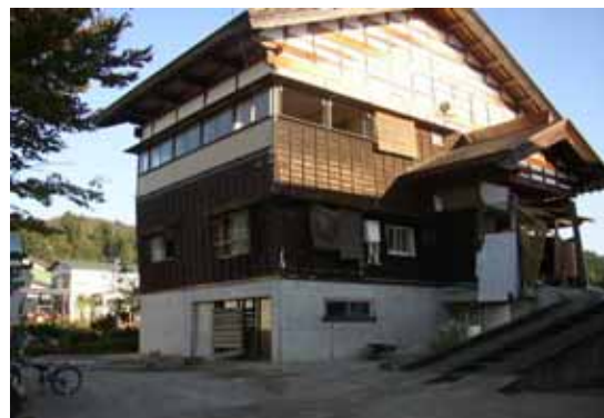
写真 8.2 被災地域に多い高床式の鉄筋コンクリート造の基礎
