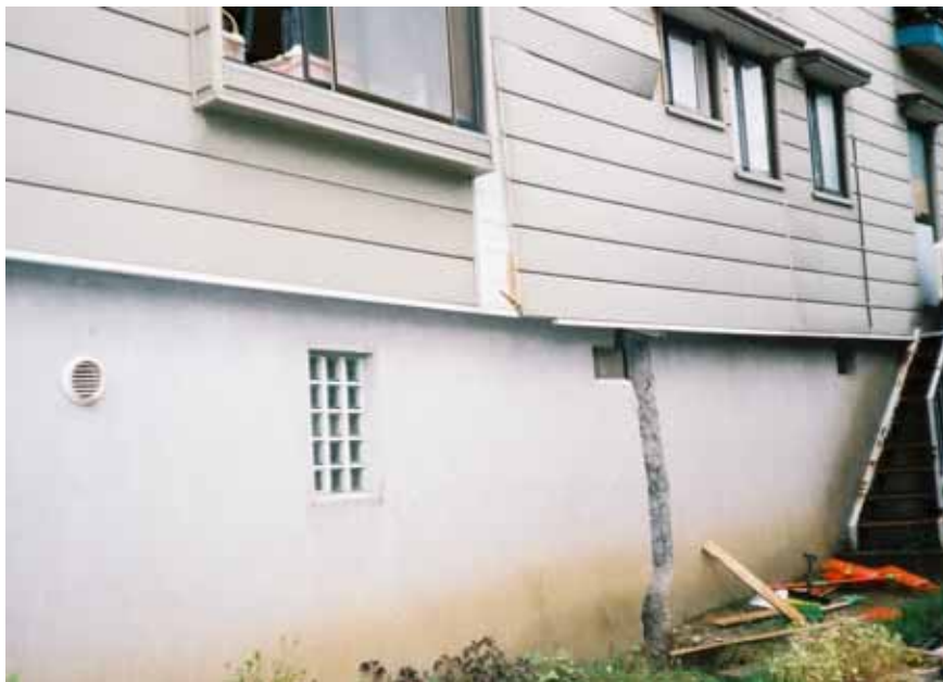
写真 8.36 戸建住宅の基礎の被害（高床式の鉄筋コンクリート造の被害） （地すべりが発生して著しい地盤変位が生じた地域で見られた例）
