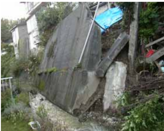
写真 8.30 宅地擁壁の被害
