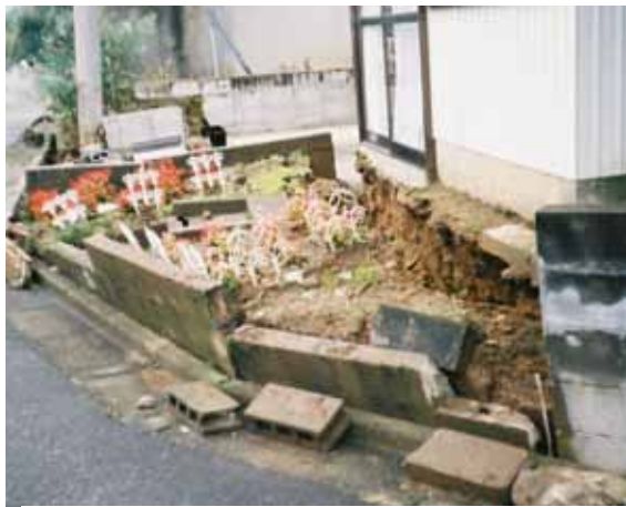
写真 8.33 宅地における低盛土（50～70cm）が崩壊することによる住宅の不同沈下や崩壊
