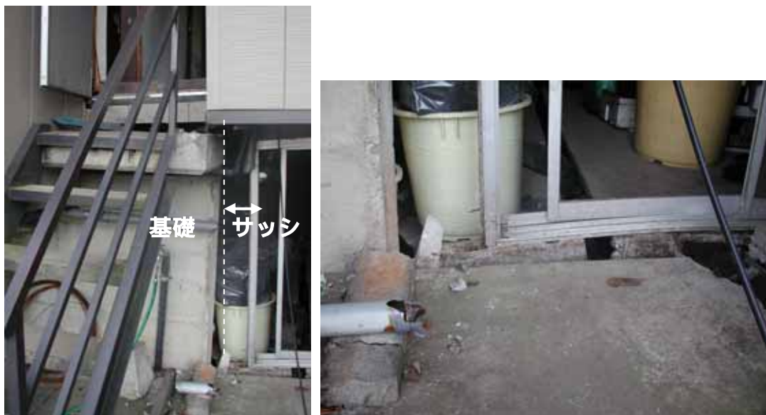
写真 8.20 高基礎の全高にわたり設けられたサッシ及び周辺の段差
