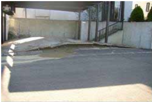
写真 8.26 液状化による地盤の隆起と宅地内の地割れ（長岡市）
