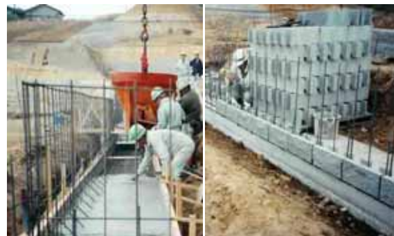
写真 8.44 直壁を有する耐土圧 ブロック擁壁 写真提供: (社) 全国宅地擁壁技術協会
