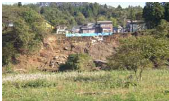
地盤変位約 1.5m 地震により離間した例
