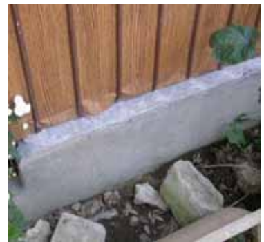
(c)床下の高い支柱・束（ろうそく基礎と呼ぶこともある） (d)無筋コンクリート 写真 8.1 被災地における古い住宅の基礎形式 （建物外周にブロック基礎を設置し、内部に高い束など設けていることが多い）
