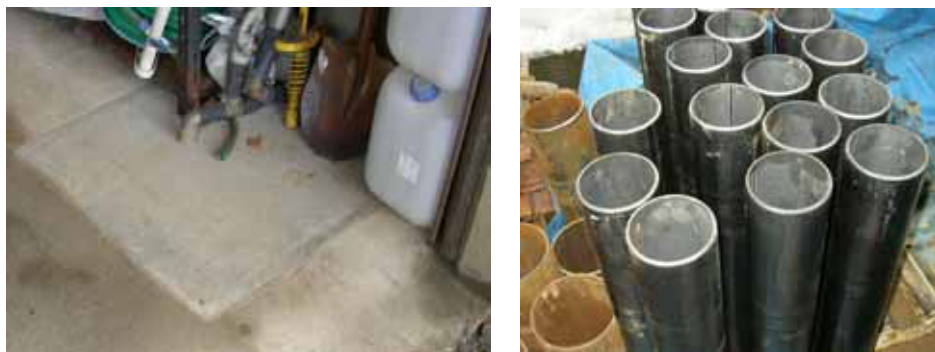
写真 8.13 鋼管圧入工法による沈下修正工事
