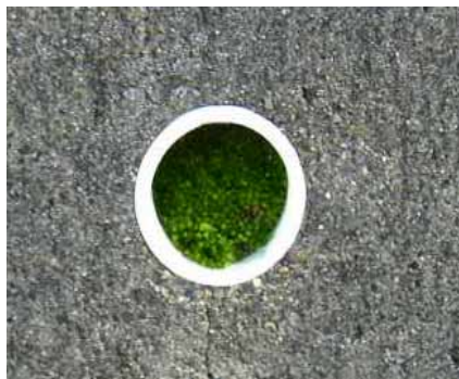
写真 8.32 擁壁の維持管理等の状況 (水抜き孔の孔詰まり、水抜き孔からの土砂流出)
