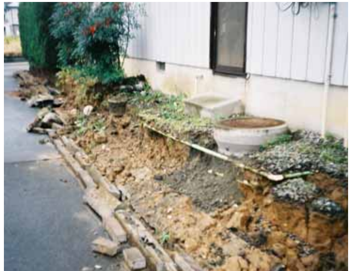
写真 8.34 低い外構ブロックの転倒例
