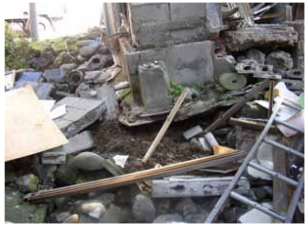
写真 8.33 宅地における低盛土（50～70cm）が崩壊することによる住宅の不同沈下や崩壊
