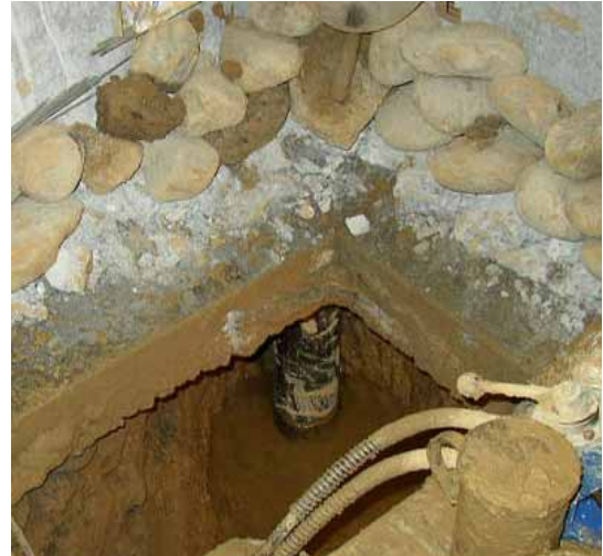
写真 8.46 積雪中に実施されていた住宅の沈下修正工事の例
