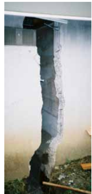
写真 8.36 戸建住宅の基礎の被害（高床式の鉄筋コンクリート造の被害） （地すべりが発生して著しい地盤変位が生じた地域で見られた例）
