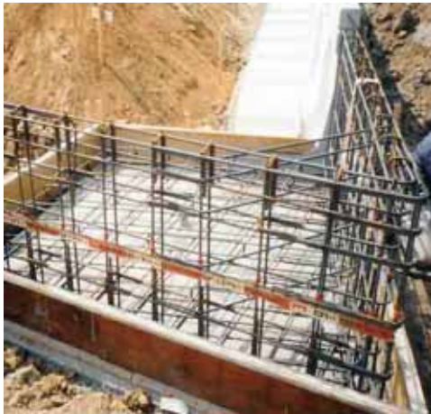
写真 8.42 コンクリート造擁壁におけるコーナー部の補強 (ハンチと壁厚の補強) 写真提供: (社) 全国宅地擁壁技術協会
