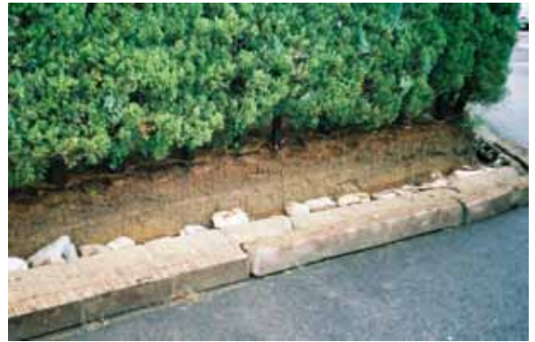
写真 8.33 宅地における低盛土（50～70cm）が崩壊することによる住宅の不同沈下や崩壊
