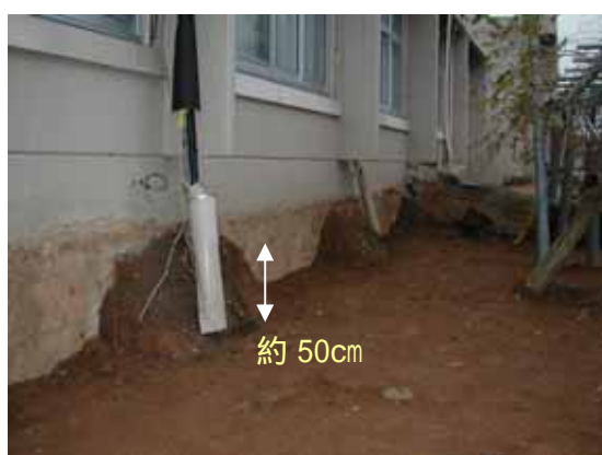
写真 8.10 校舎周辺の地盤の移動
