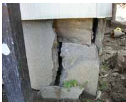
1/20 以上傾斜して大破した布基礎（柏崎市）
