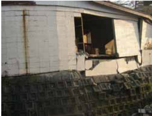
写真 8.35 戸建住宅の基礎の被害例 (ブロック基礎、石積み基礎、無筋コンクリート造基礎など)
