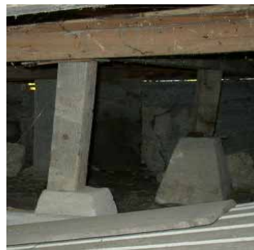
(c)床下の高い支柱・束（ろうそく基礎と呼ぶこともある） (d)無筋コンクリート 写真 8.1 被災地における古い住宅の基礎形式 （建物外周にブロック基礎を設置し、内部に高い束など設けていることが多い）
