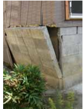
写真 8.35 戸建住宅の基礎の被害例 (ブロック基礎、石積み基礎、無筋コンクリート造基礎など)
