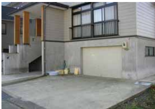
写真 8.2 被災地域に多い高床式の鉄筋コンクリート造の基礎
