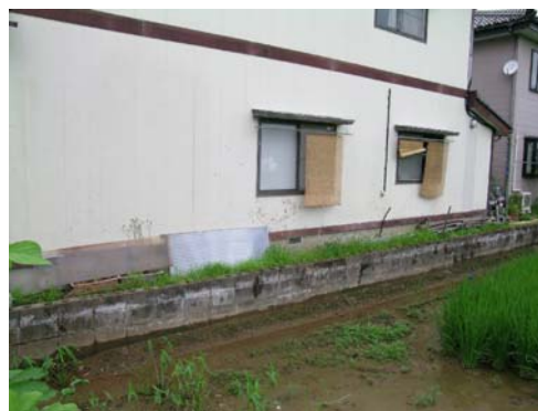
水田側の擁壁
