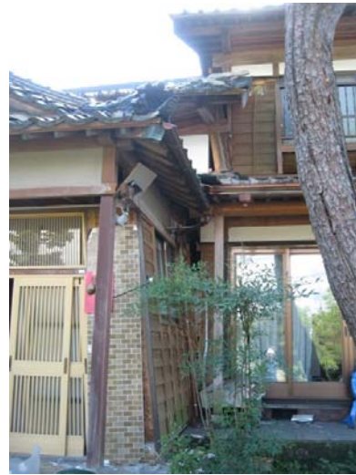
平屋部分と増築部分の接合部分
