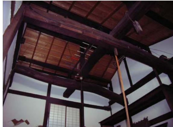
吹抜部分上部
