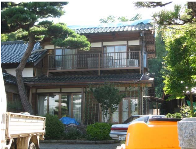
増築部分の外観
