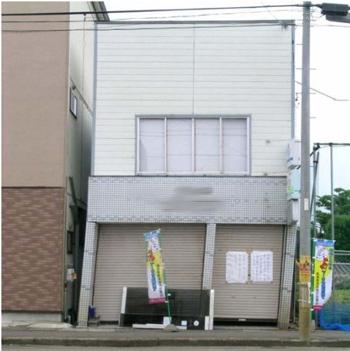
道路からの全景
