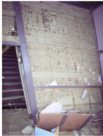
壁土の剥落
