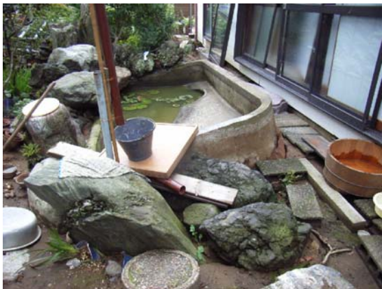
池の浮き上がりと噴砂痕
