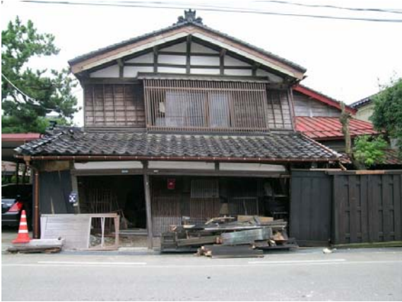
道路からの全景
