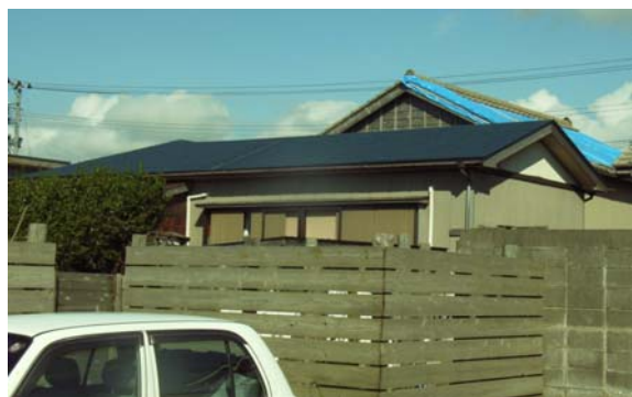
手前の青い金属屋根が増築部分
