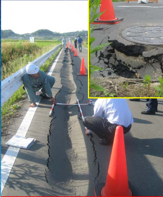
築館消防署裏 約200mにわたり路面が連続的に沈下
