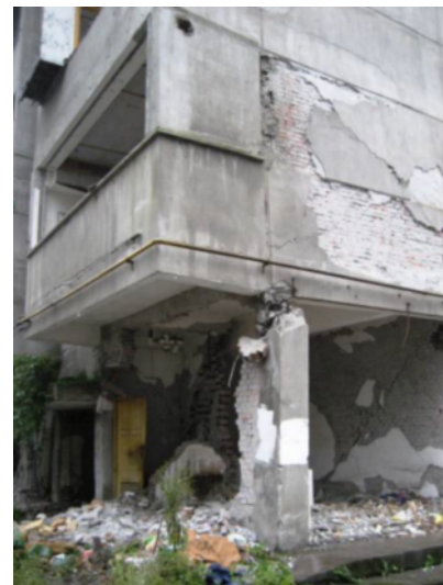
写真 5.1 1階が完全に崩壊した学生寮(映秀) 写真 5.2 写真 5.1 の妻面の1階部分
