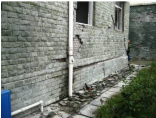
写真 5.13 基礎と上部構造のずれ（映秀） 写真 5.14 基礎と柱脚の詳細（映秀）
