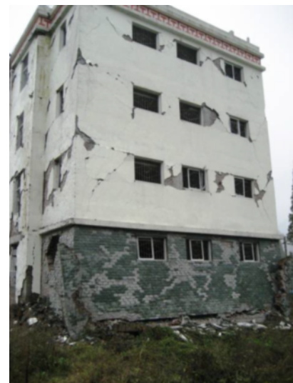
写真 5.1 1階が完全に崩壊した学生寮(映秀) 写真 5.2 写真 5.1 の妻面の1階部分
