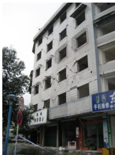
写真 5.16 非構造壁の破壊 ( 漢旺 )
