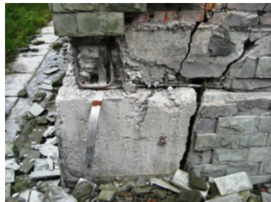
写真 5.13 基礎と上部構造のずれ（映秀） 写真 5.14 基礎と柱脚の詳細（映秀）
