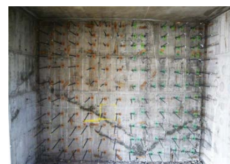
写真 2 施工精度検証および付着強度試験 (実建物)
