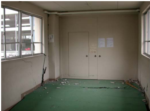
写真-6.11 校舎と講堂の渡り廊の被害
