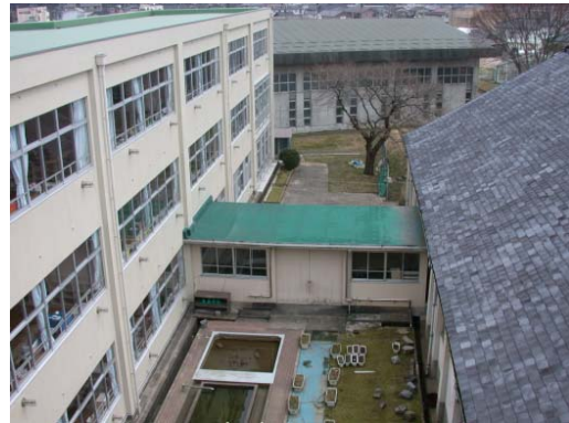
写真-6.10 校舎棟と講堂の渡り廊下
