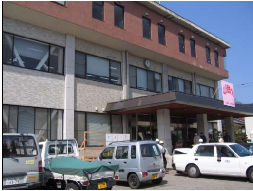
写真-6.3 輪島市門前総合支所
