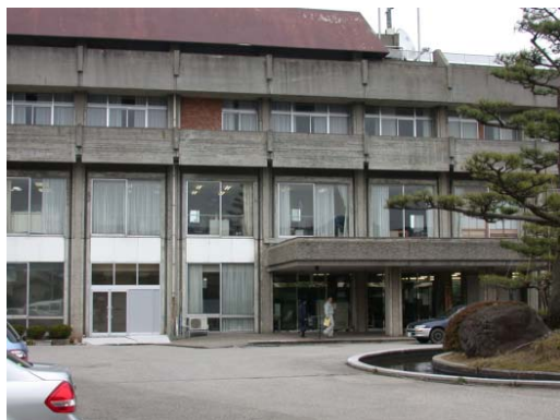
写真-6.14 七尾市役所田鶴浜支所
