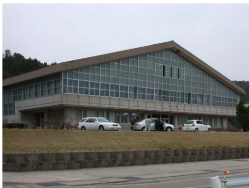
写真-6.13 七尾市中島体育館
