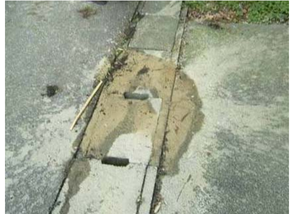
写真-4.2 噴砂あと（写真-4.1 直近） （輪島市門前町和田地区）
