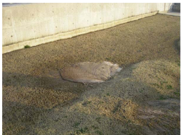
写真-4.10 オキシレーションディッチ槽周 辺の噴砂跡（門前水質管理センター）
