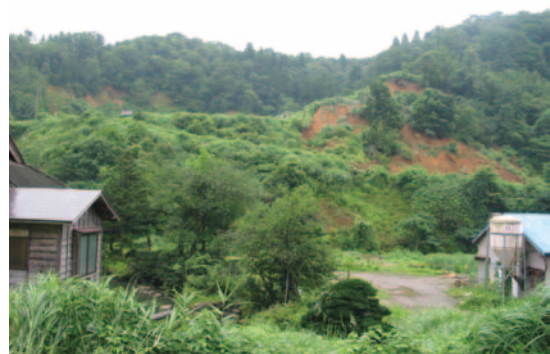
写真-3.5 内陸部で発生した崩壊（長岡市（旧小国町）渋海川支川国沢川の右岸）
