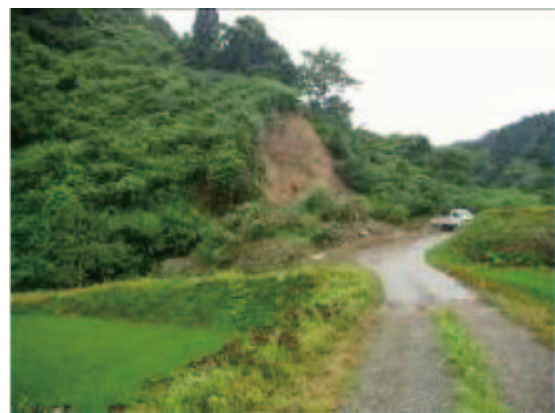
写真-3.2 新潟県長岡市小国町の河道閉塞箇所の点検状況
