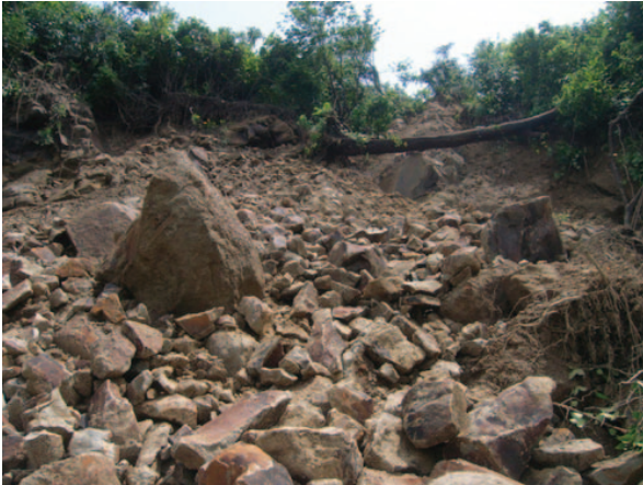
写真-3.13 崩落土砂(7月19日撮影)
