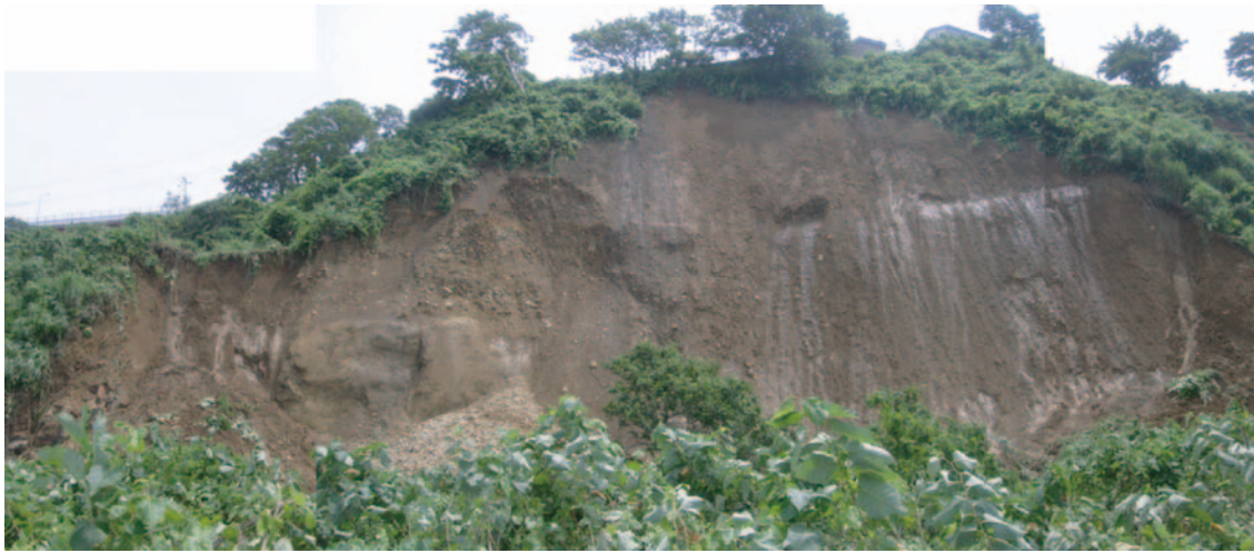
写真-3.8 崩落面の状況（7月19日撮影）
