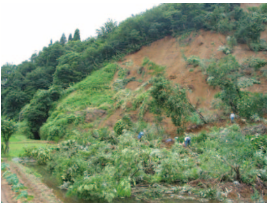
写真-3.4 内陸部で発生した崩壊（長岡市（旧小国町）渋海川支川土口川の右岸）
