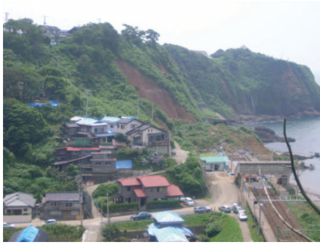
写真-3.7 地すべり全景（7月19日撮影）
