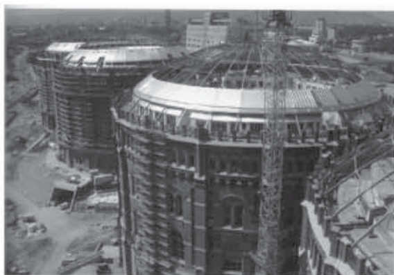
Fig. C 再利用(屋根架構の施工例)
