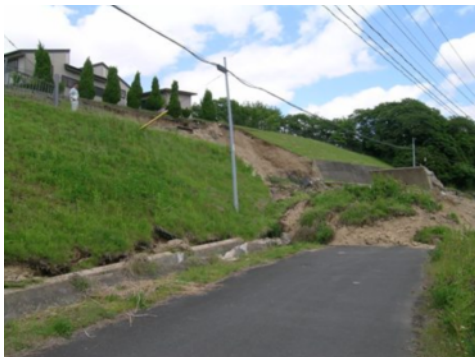
(a) 南側斜面擁壁の崩壊
