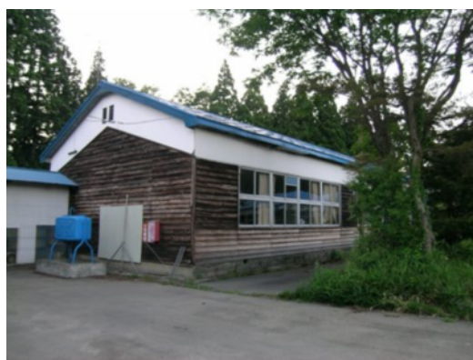
(b) プール北西側にある木造校舎
