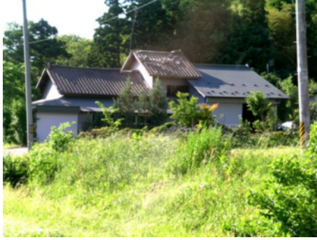
(a) 住宅の棟瓦の落下
