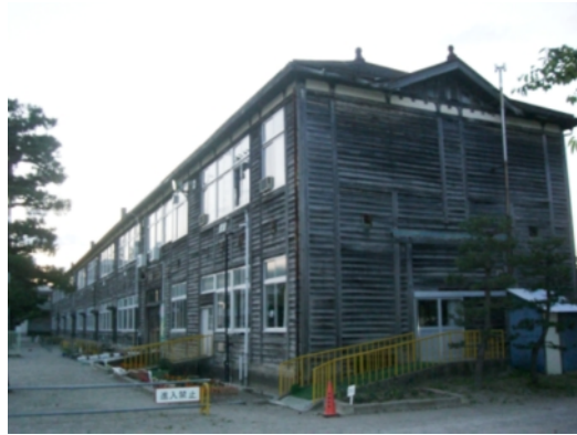
図-2.3.28 J小学校旧校舎（北校舎）の外観（無被害）
