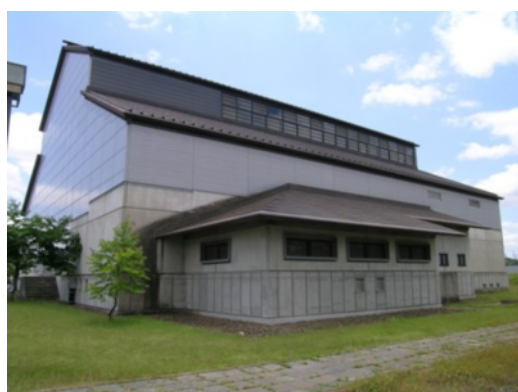
図-2.3.8 D建築物北面（高窓に被害なし）
