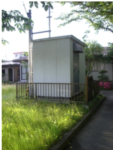
図-2.3.23 強震計設置状況(三日町公園)
