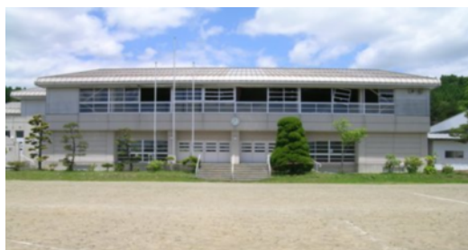
図-2.3.5 C 小学校体育館南側全景
