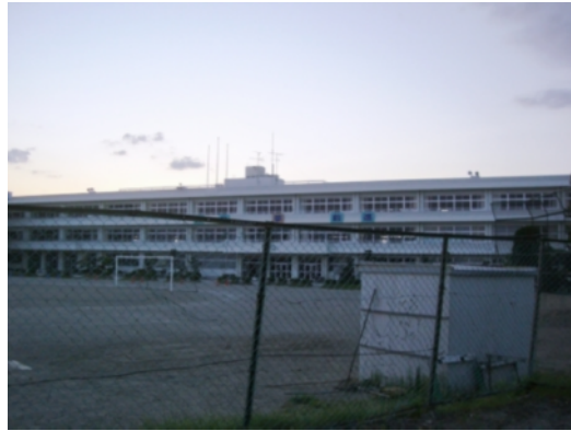
図-2.3.26 I 中学校新校舎外観
