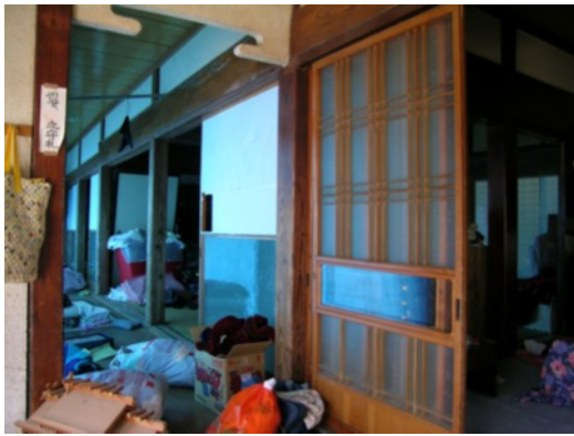
(c) 同住宅内部（特に躯体損傷なし）
