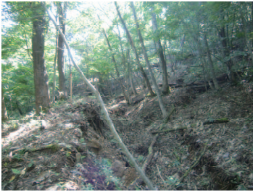
写真-2.2.24 地点 d に生じた変状
