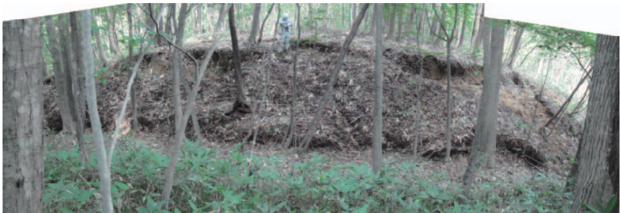
写真-2.2.22 地点 b に生じた変状
