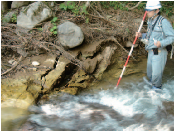
写真-2.2.10 地点fの河床での段差
