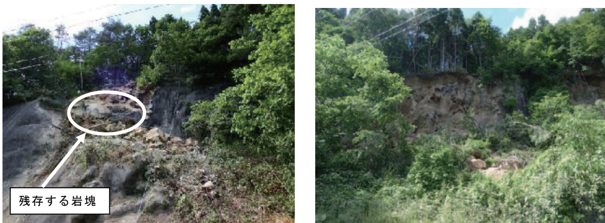
(a) 吹付のり面の状況
