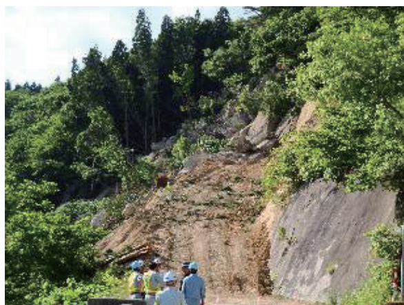
図-7.3.5 一関市巖美町板川 矢櫃ダム直上流の岩盤崩壊
