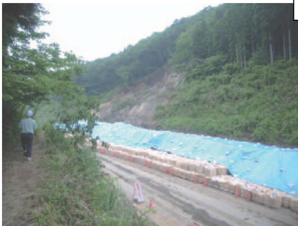
(a) 斜面全景 (斜め側方から)
