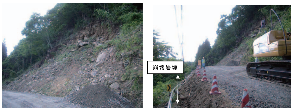
(a) 斜面全景（斜め側方から）
