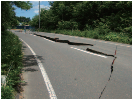
図-7.4.4 花巻衣川線、沢と平行に建設されていた盛土の被害
