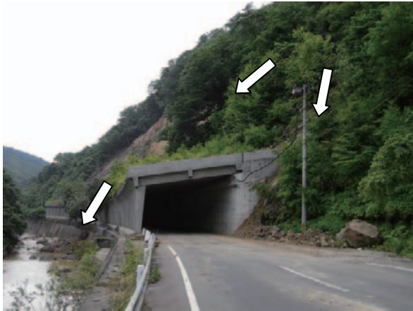
(a) 崩壊箇所の全景
