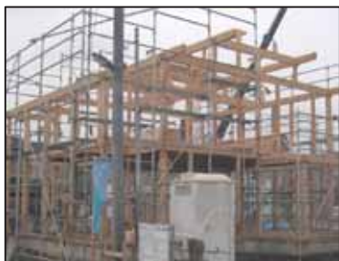
国産材による骨太な構造土台、通し柱は4.5寸以上
