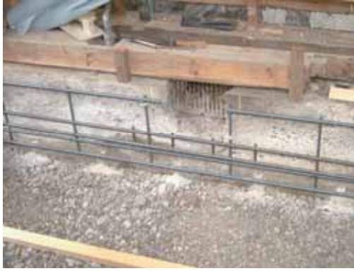
◆RUM-BR工法：配筋施工中
