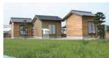
屋内環境 測定 実験棟
