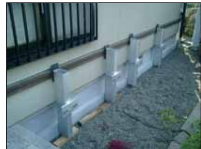
図 2.床下作業中は建物を固定する
