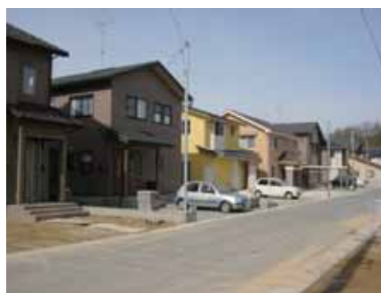
●外構整備が未完成のままの住宅
