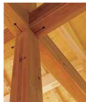
断面欠損の少ない金物接合
