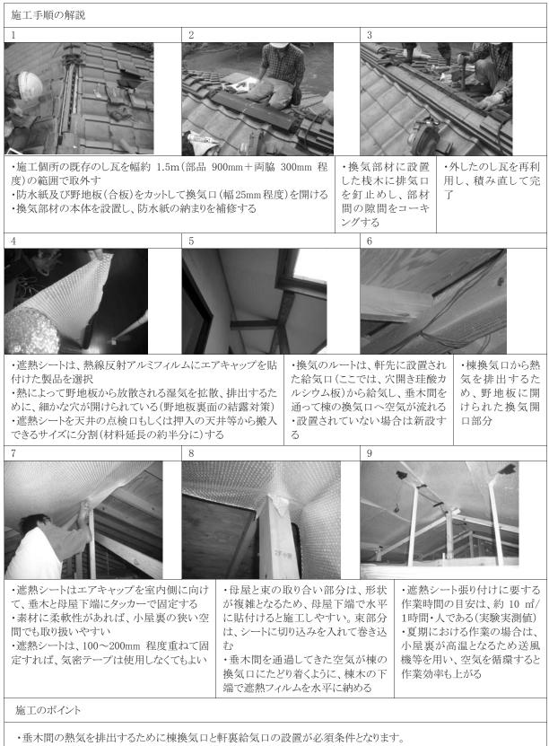
・棟換気口から熱気を排出できるように、棟木の下端で遮熱シートを水平に貼付け垂木下端に空間を確保します。 ・遮熱シートは、母屋と平行に貼付けると効率的です。また、母屋と束の取合い部分は、形状が複雑となるため、母屋 の下端で水平に貼付けると施工しやすくなります。
