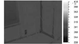
図 25 改修後(和室西戸境壁入り隅)(改修後:室内 31.5°C、外気 12.5°C)
