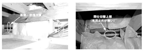
図3 壁の実況見分の事例
