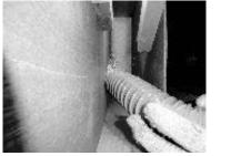
図 11 壁体内へ EPS を吹き込 む様子
