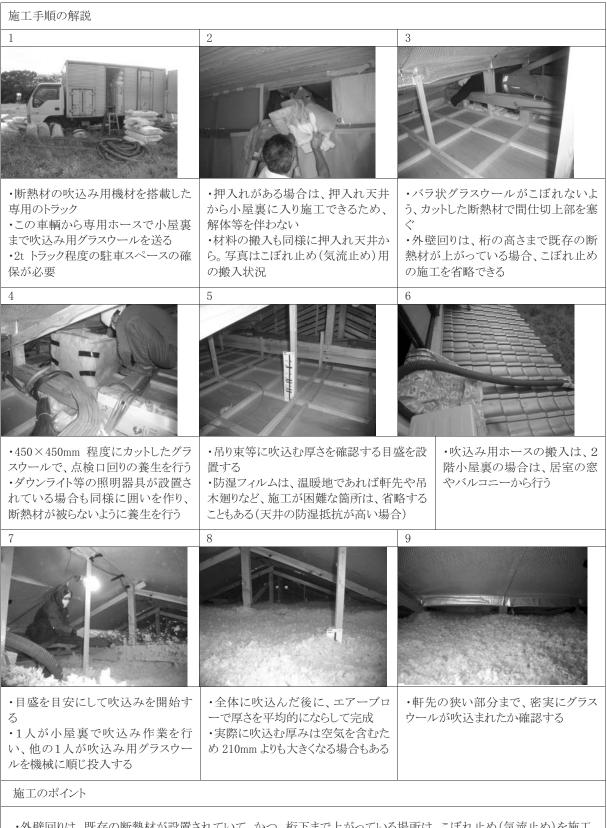
・外壁回りは、既存の断熱材が設置されていて、かつ、桁下まで上がっている場所は、こぼれ止め(気流止め)を施工 する必要はありません。
