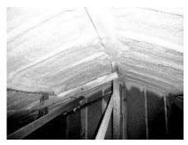
図9 垂木の高さ分の断熱材を吹付けた様子
