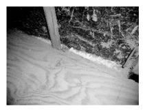
図8 床下から吹付けた断熱材が壁と床の隙間か ら床上に漏れ出た様子
