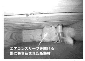
図4 エアコン設置工事の際に生じた断熱欠損の例
