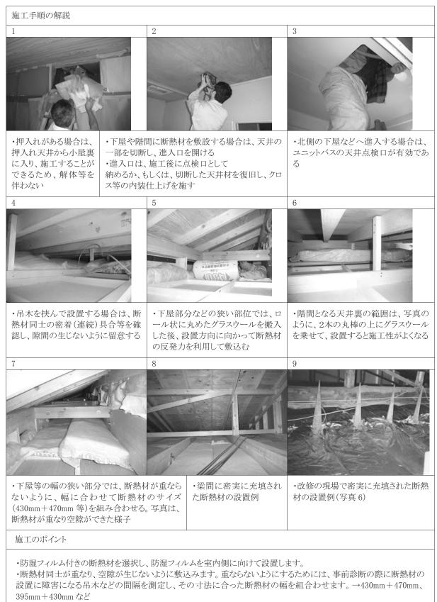
・階間などの狭い部分で作業者が入れない場合は、長さ 1.2m ほどの棒を2本用い、進入口から断熱材を搬入後、その上を滑らせるように挿入すると、施工性が向上します(写真6)。
