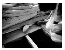
図7 床下への吹付け施工の様子
