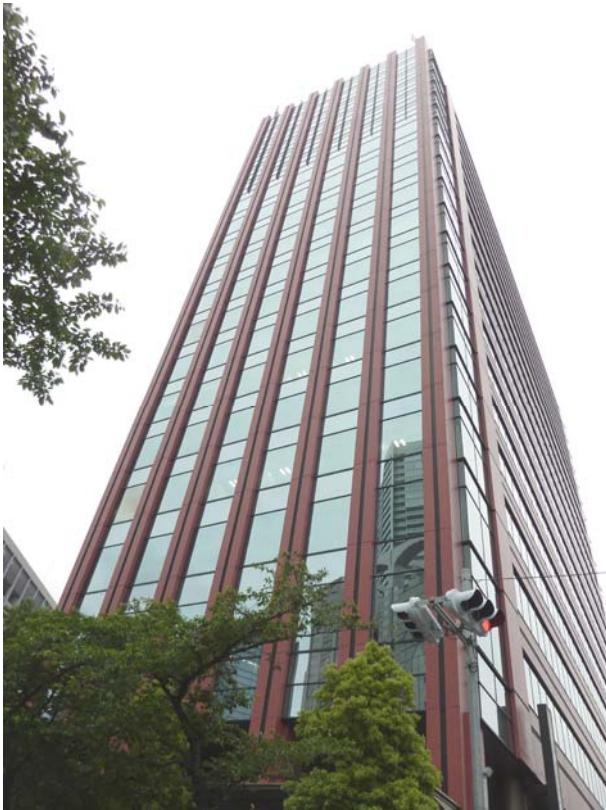
図 4.5 柱カバー形式（縦連窓タイプ） 取付け階の構造柱を覆う形で取付けられる。2層にまたがる形式で取付けられるため、ロッキング方式などで直接層間変位を吸収する。
