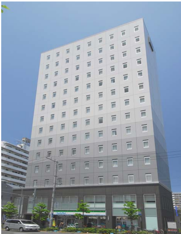
図 4.3 層間形式 (壁パネルタイプ)
