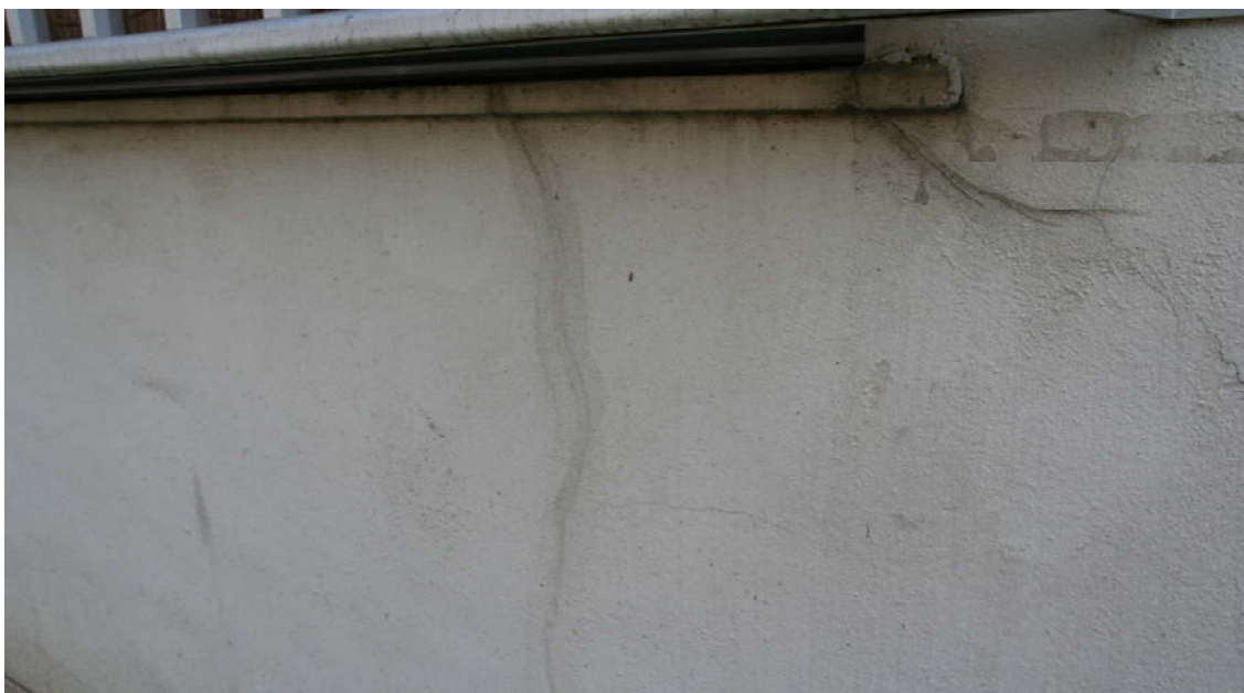
写真 3.1 Uカットシール材充填工法で補修した施工例
