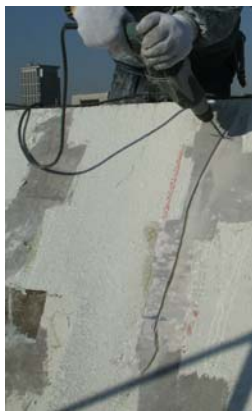
f.ピンニング孔の穿孔
