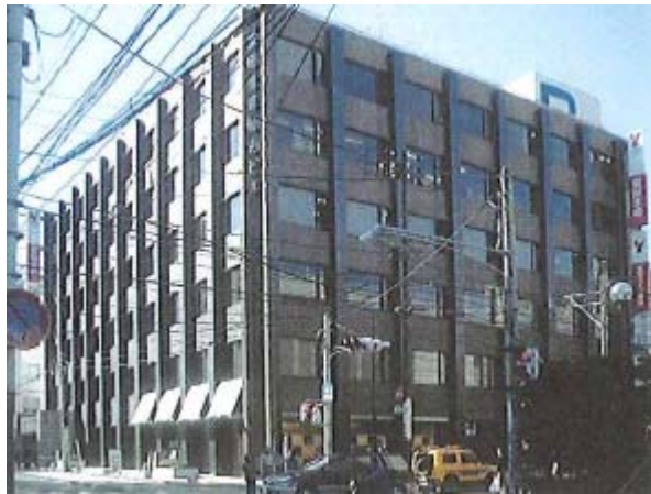
外壁全体をカーテンウォールにて改修した例
