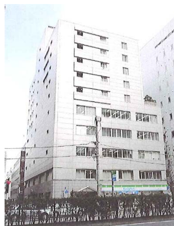
外壁腰部をパネルにて改修した例
