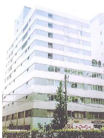
外壁腰部をパネルにて改修した例
