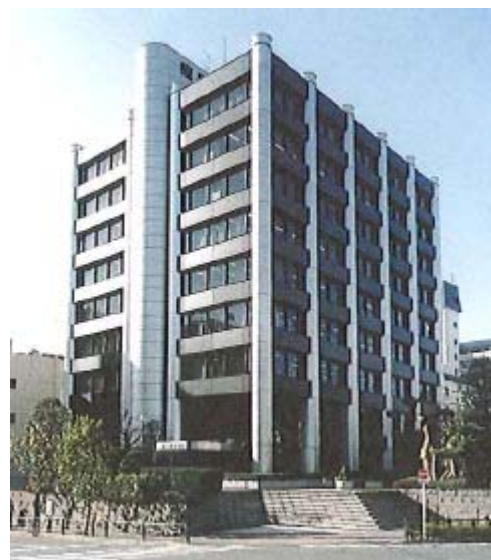
窓、外壁を、サッシ・パネルにて改修した例
