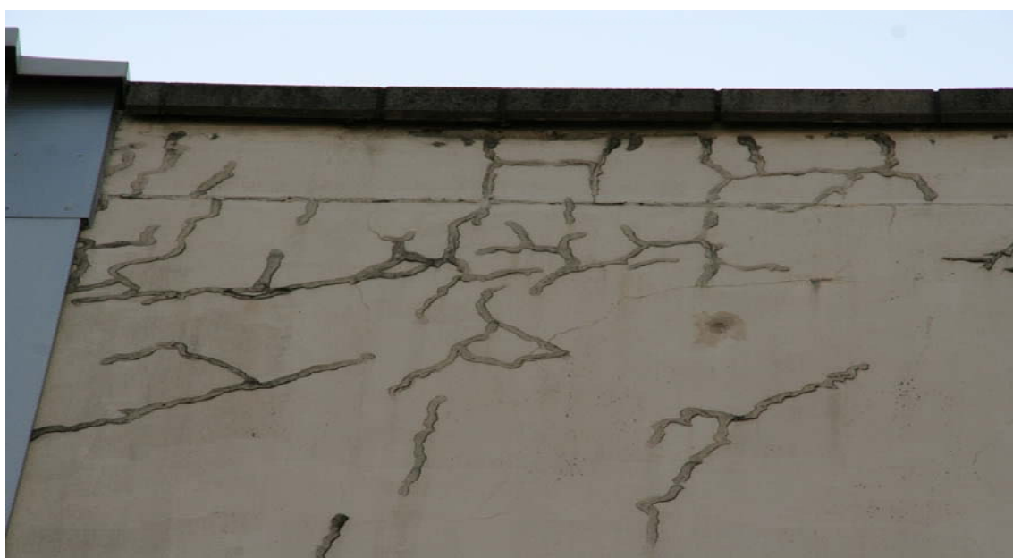
写真 3.2 シール工法で補修した施工例
