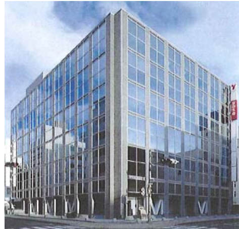
外壁全体をカーテンウォールにて改修した例
