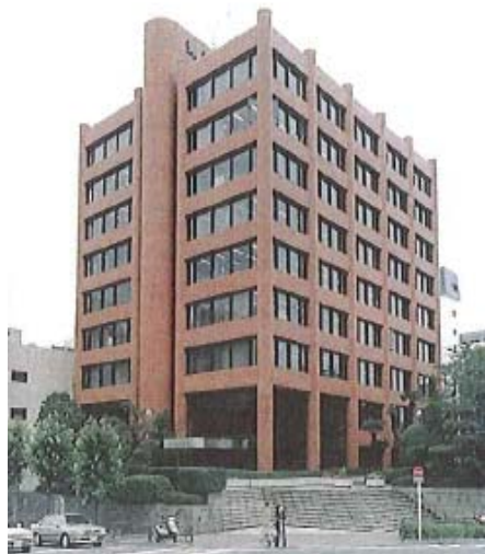
窓、外壁を、サッシ・パネルにて改修した例
