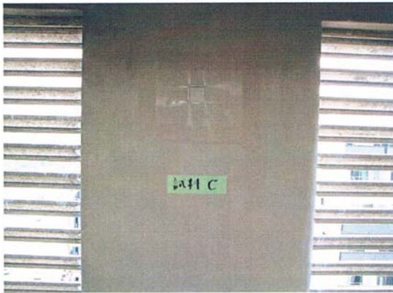
写真 3.9 施工後 20 年の外壁複合改修構工法改修面(②広島の物件のペントハウス内壁)
