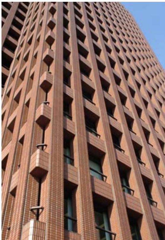
図 4.6 柱・梁カバー形式 スパンドレルと柱カバーの複合形式で、 層間変位の処理方法はそれぞれの形式と同様である。
