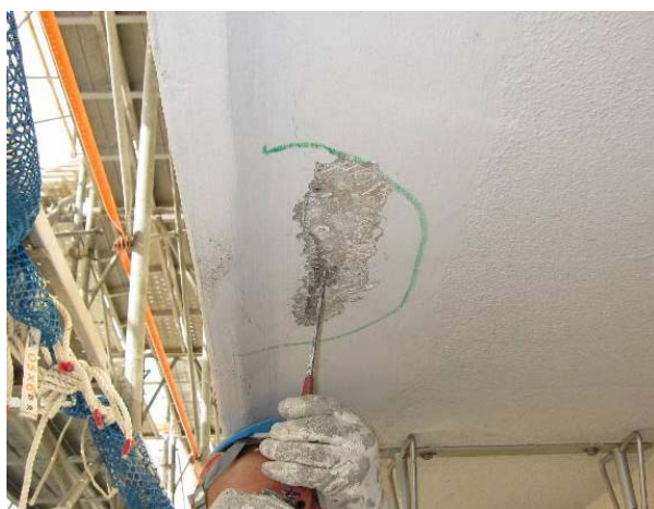
写真 3.8 集合住宅のベランダ軒裏天井に発生したふくれ(①千葉市内の物件)
