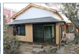
庭園からみる座敷部
