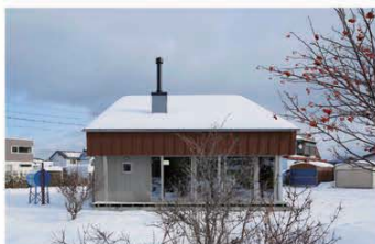
写真3：S-house 外観：無落雪勾配屋根とカラマツ外装材を採用
