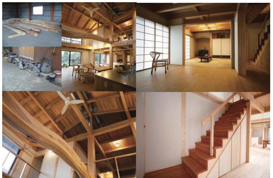
解体した材を生かしたづくり
