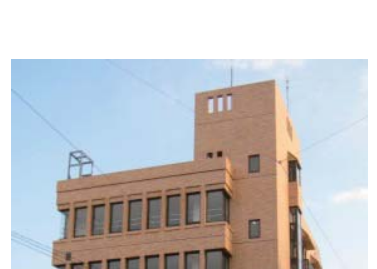
共同住宅に改修した 中心市街地の事務所ビル
