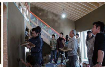
写真5：S-house 下川の土による壁塗りワークショップ風景
