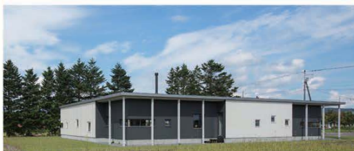
写真1：K-house 外観：無落雪フラットルーフとカラマツ外装材を採用
