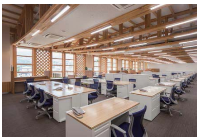
柱がない広い空間の2階フロア
