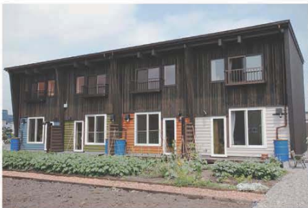
南面外観：外壁は主に北海道産のから松材と道南スギ材を使用。手前に専用・共同菜園が広がっている
