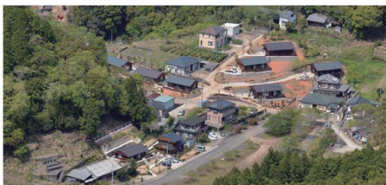
斜面地を活かした復興公営住宅(高森集落)
