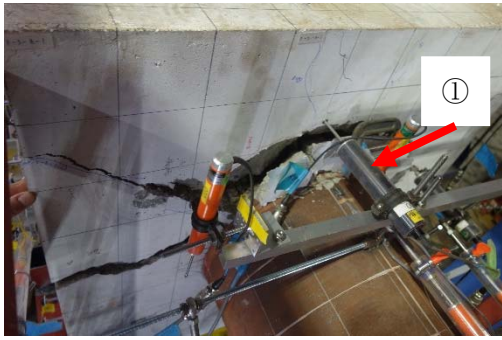
拔出し変位計①
