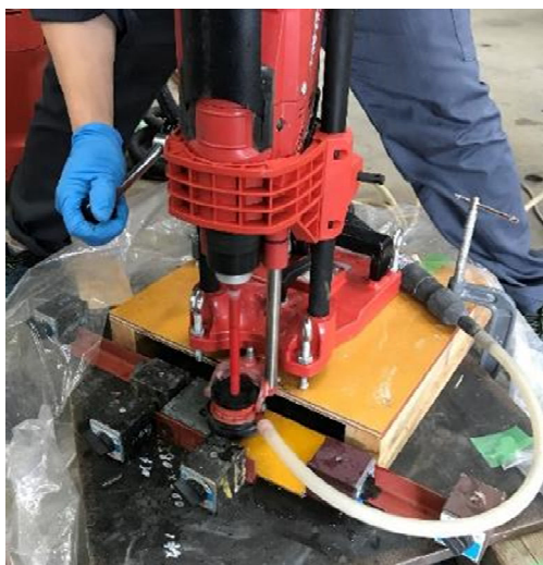
(c) 削孔状況
