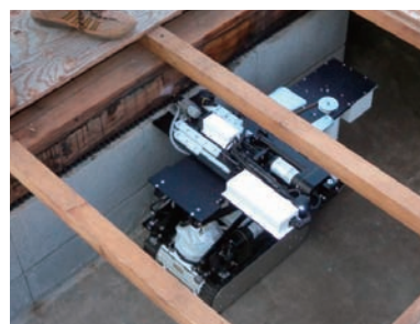
図 5 劣化診断装置の使用性調査
