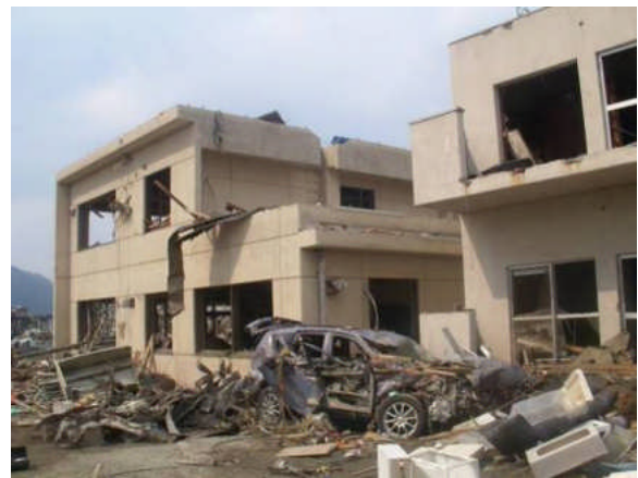
(南東から見る)
