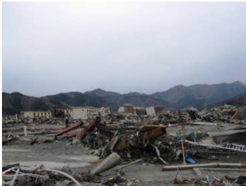
写真1 大槌町の集合住宅全景
