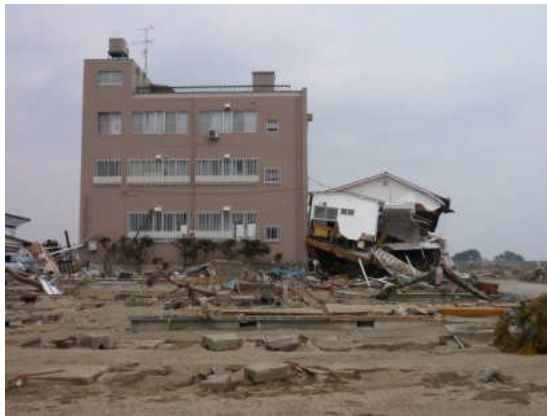
写真1 事務所ビル (背面)
