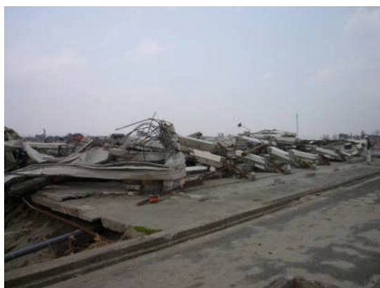
写真1 倒壊した建物
