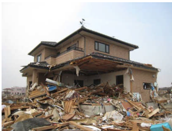
写真3 1階の一部が損壊
