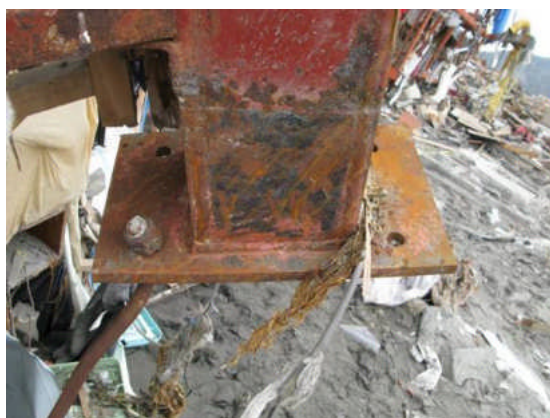
写真4 柱脚ベースプレート
