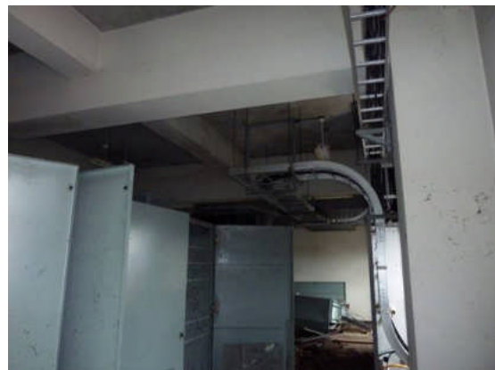
写真 4 2 階床を有する棟の内部
