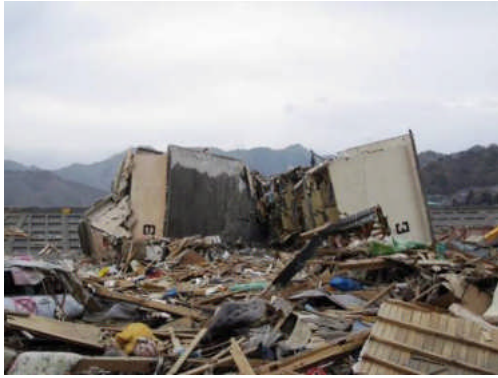
写真 8 移動し転倒した住棟 2 棟
