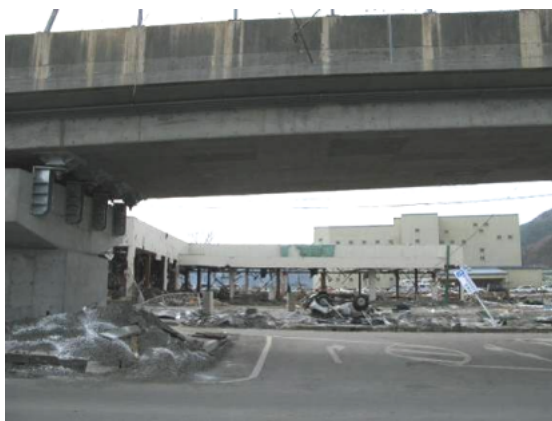
写真1 建物外観(1) (上は釜石バイパス)
