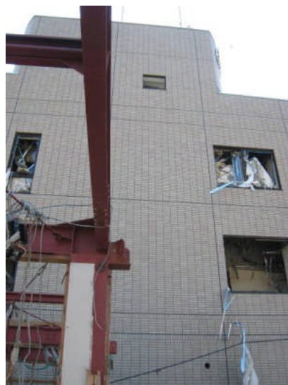
写真4 ペントハウス天井に痕跡
