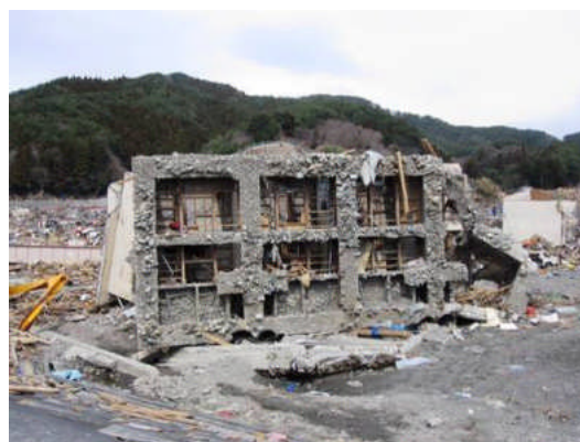
写真3 転倒した基礎断面
