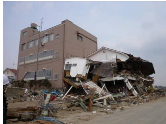
写真2 隣の建物が倒れ掛かっている
