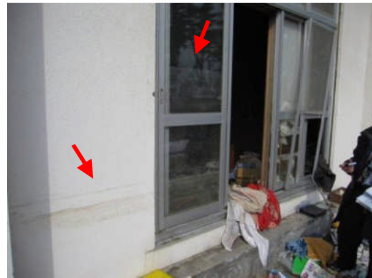
写真2 1階の浸水痕
