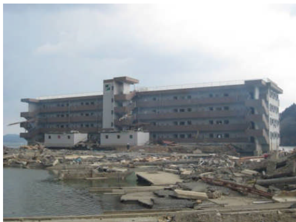
写真1 建築物の外観
