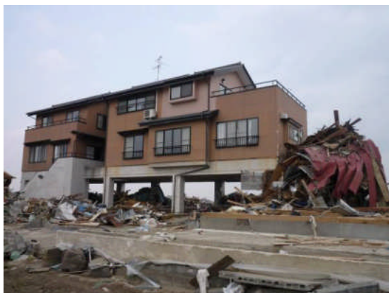
写真1 混合構造建物
