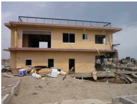
写真 1 RC 造壁式建物
