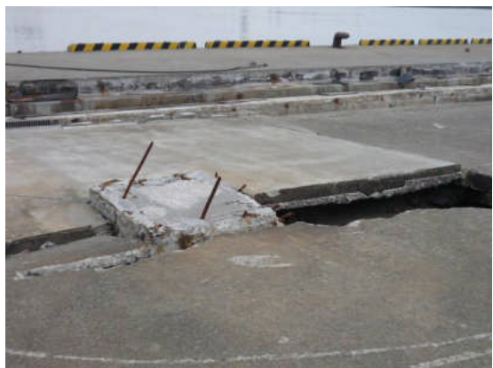
写真3 独立柱 (1本だけ残存、他は流失)
