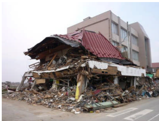
写真2 倒壊した建物 (正面)
