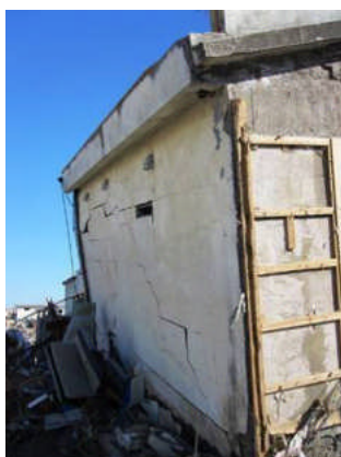
写真3 コンクリートブロック壁
