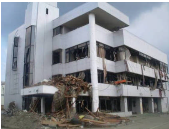
写真3 建築物外観 (南東面)
