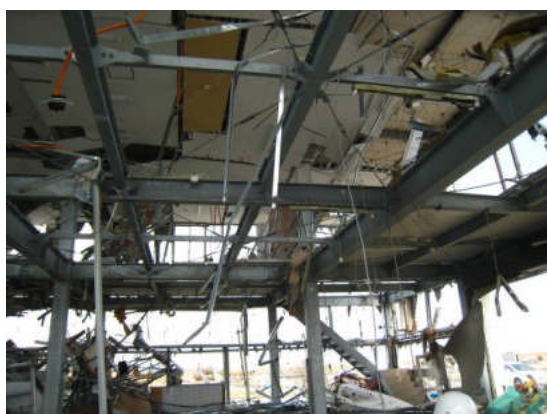
写真4 2階床の流失
