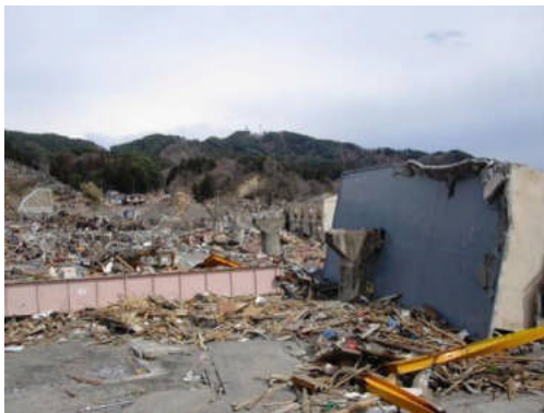
写真 10 移動し転倒した住棟 2 (橋脚に倒れかかっている)
