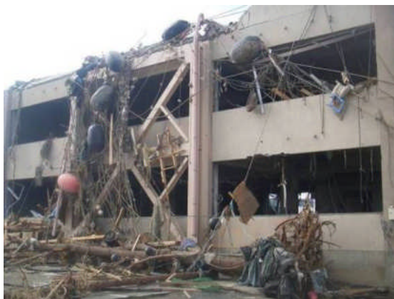
写真3 建築物外観 (東面)
