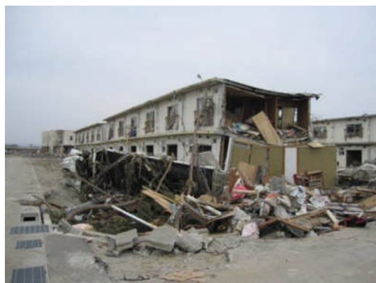
写真1 建物東端1戸分の崩壊
