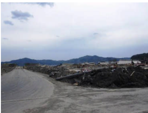
写真 14 破壊された近所の防潮堤
