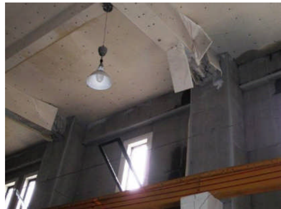
写真 2 3 階梁下端筋の降伏
