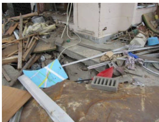
写真2 周辺地盤の洗掘
