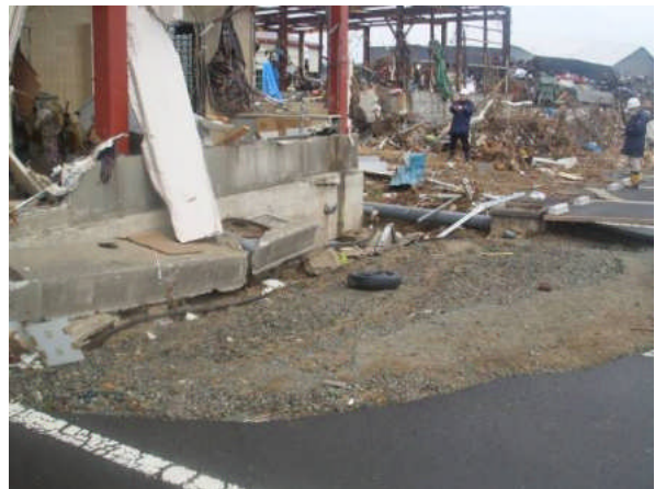
写真4 地盤の洗掘
