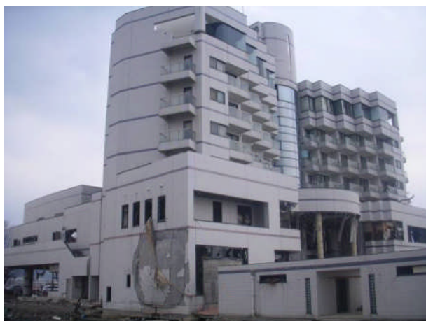
写真1 ホテルの外観
