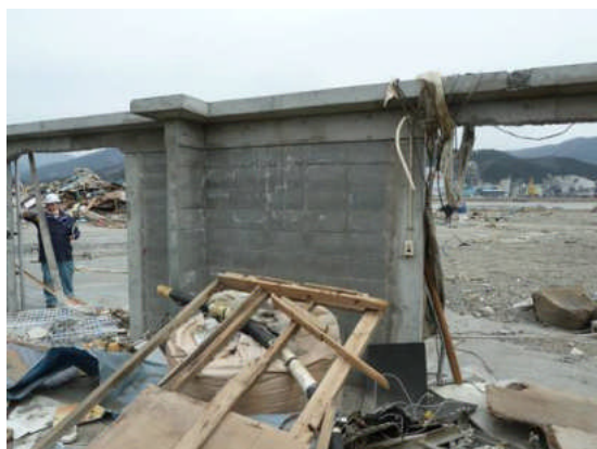
写真4 ブロック壁を挟むRC柱
