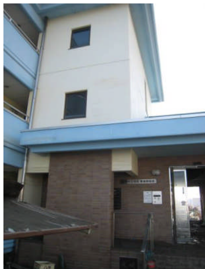
写真2 エントランス部
