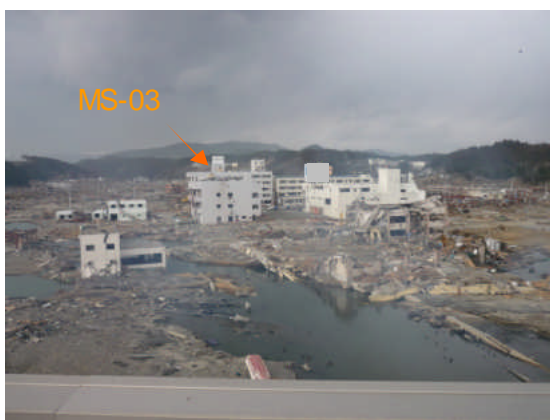
写真1 建築物の遠景 (海側から)
