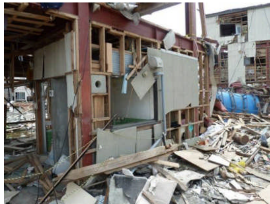
写真2 コンクリートブロック壁の区画
