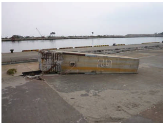
写真3 独立柱 (1本だけ残存、他は流失)
