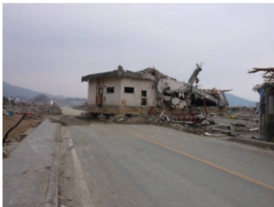
写真1 津波で建物が道路上に移動
