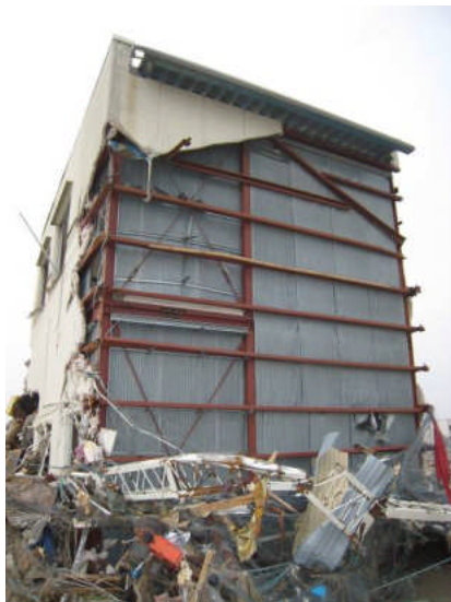
写真3 外壁が流失
