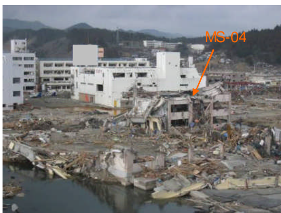
写真1 建築物の遠景 (海側から)
