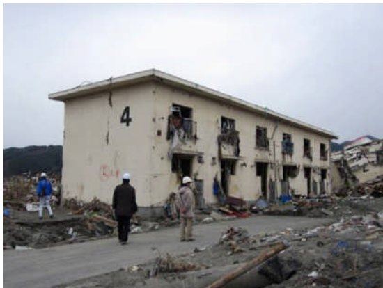
写真1 残存した集合住宅棟
