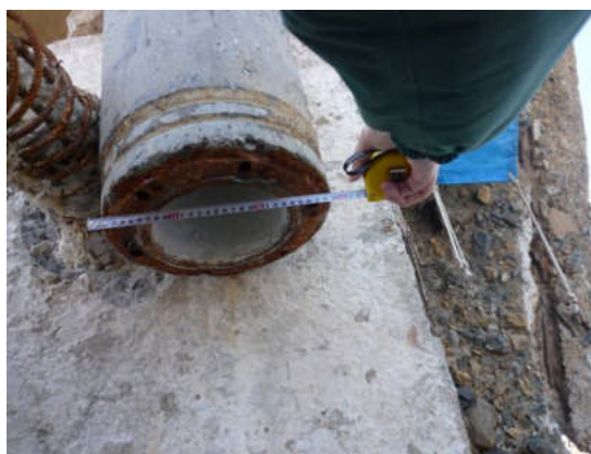
写真 4 PC 杭と杭頭中詰め部
