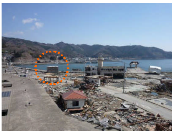
写真 1 転倒建物 (丸印、海側に転倒)
