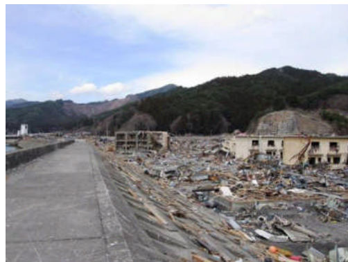
写真 13 川沿いの防潮堤のすぐ横に位置する
