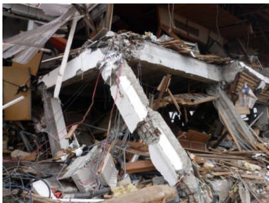
写真3 1階 RC 造架構
