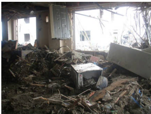
写真2 1階内部の状況
