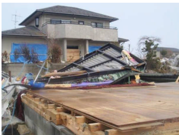
写真3 残存した住宅と上部構造が流失した住宅
