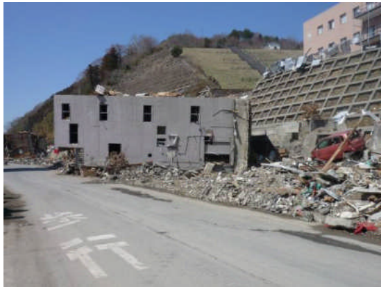
写真1 移動・転倒した建物
