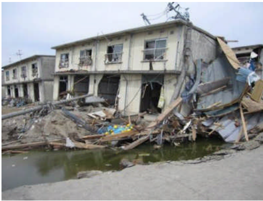
写真1 周辺地盤の洗掘による建物傾斜
