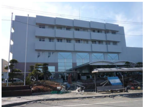
写真4 建物（東面、港側）
