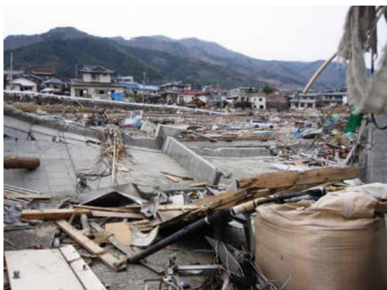
写真3 転倒したコンクリートブロック壁(1)
