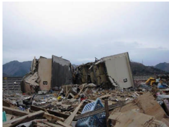
写真2 転倒した集合住宅棟
