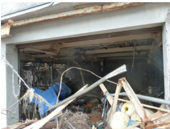
写真3 内部のコンクリートブロック壁
