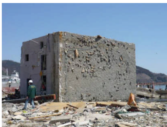
写真 2 建物底面 (直接基礎)
