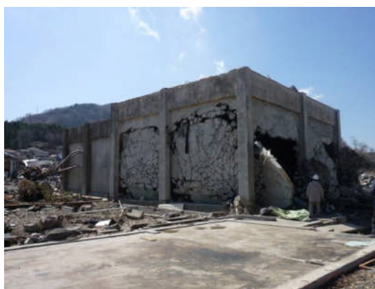
写真2 建物外観(北東側)
