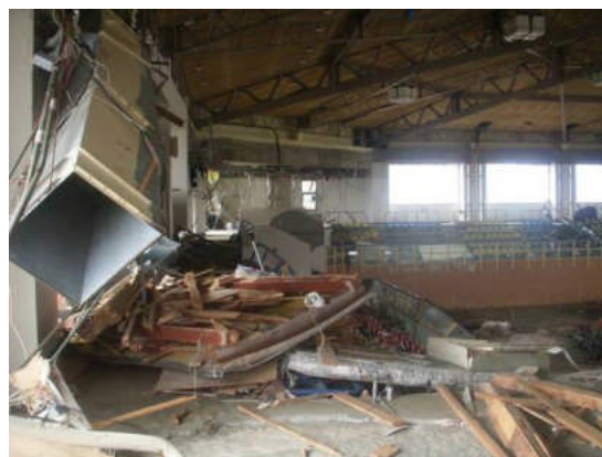
写真3 体育館内部の状況
