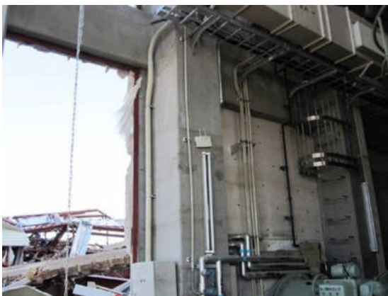
写真 3 架構内部の RC 耐震壁
