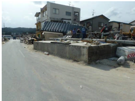
写真4 移動した水門
