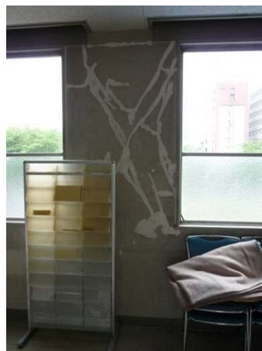
写真 B-24 方立て壁の被害内観 (雨漏り防止のための暫定的な補修)
