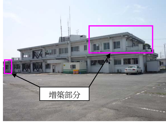
写真 B-48 建築物外観（北側）
