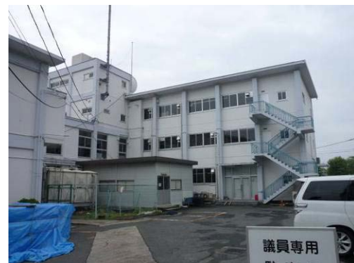
写真 B-32 建築物外観 (北面)
