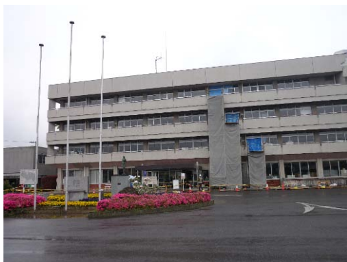
写真B-13 建築物外観
