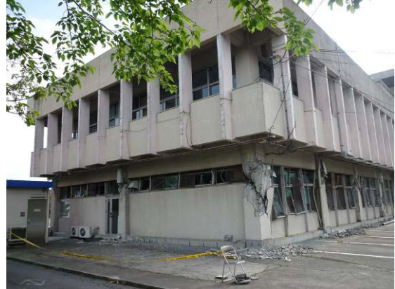
写真 B-42 建築物外観（東側）
