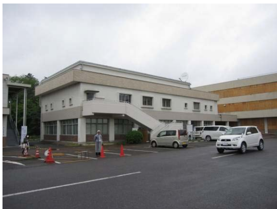
写真 B-10 建築物外観
