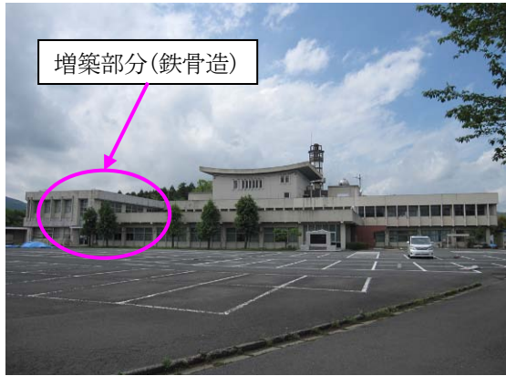
写真 B-41 建築物外観（南側）
