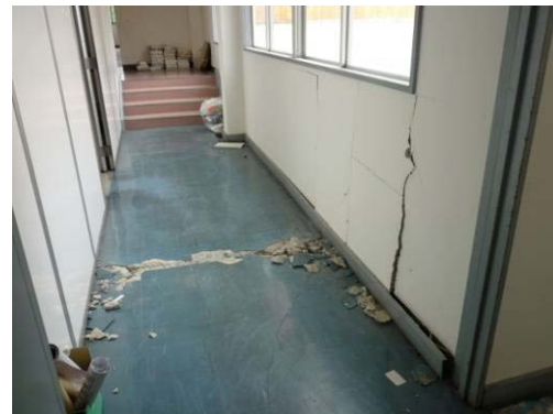
写真 B-5 建築物 B' との接続部 (2 階)
