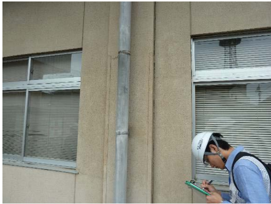
写真 B-19 無損傷の袖壁付き柱 (1階)
