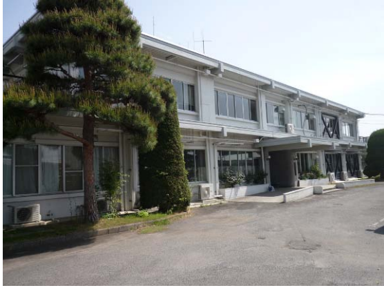
写真 B-47 建築物外観（南側）
