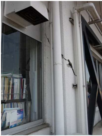
写真 B-49 補強ブレースが取り付け柱の構面内および構面外に生じたせん断破壊 (C-8柱)
