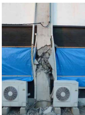
(b) 短柱せん断破壊
