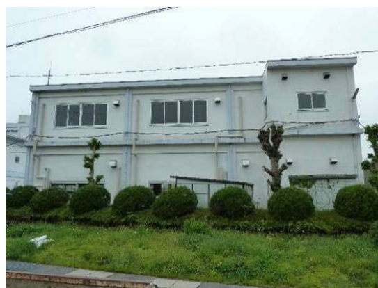
写真 B-38 建築物外観（北面）
