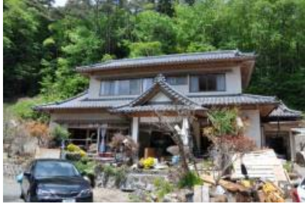
写真 6. 4. 2-7 浸水深 5m の場所に建ち、流失を免れた木造住宅
