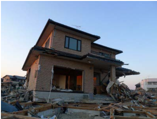
写真 6. 4. 1-13 べた基礎ごと建設地から移動し残存した例（右は当初位置に残る鋼管杭）
