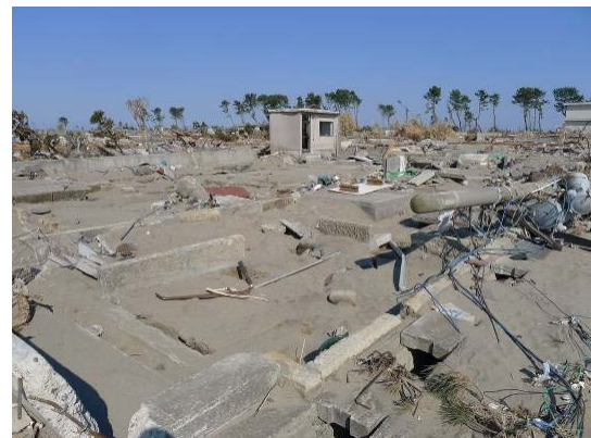
写真 6. 4. 1-17 上部構造と土台も流失した例
