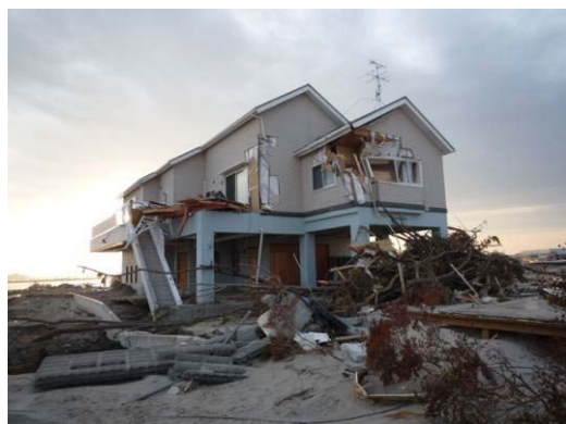
写真 6. 4. 1-10 1階RC構造（ピロティ形式）で残存する事例(1)
