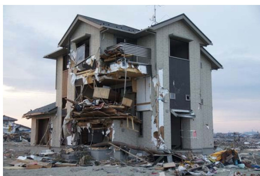
写真 6. 4. 1-12 残存する木質プレハブ工法による3階建て住宅
