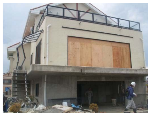
写真 6. 4. 1-11 1階RC構造（壁式構造）で残存する事例(2)
