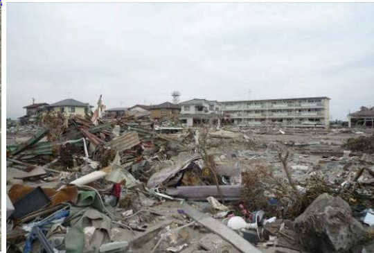
写真 6. 4. 1-3 津波の入射方向に建つ建築物により津波波力が軽減し、残存したと考えられる例（名取市閑上地区）
