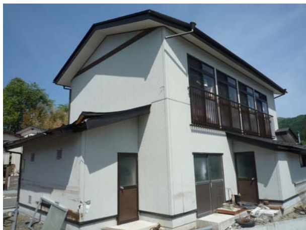
写真 6.4.2-4 最大浸水深が7mを超える場所に建ち、ほぼ無被害の木造住宅
