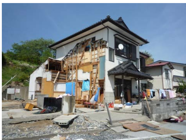
写真 6.4.2-6 最大浸水深が7mを超える場所に建ち、流失を免れた木造住宅
