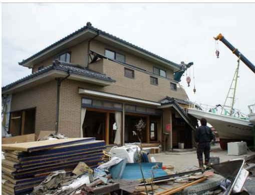
写真 6. 4. 1-6 津波の作用方向に開口が多く残存したと考えられる事例
