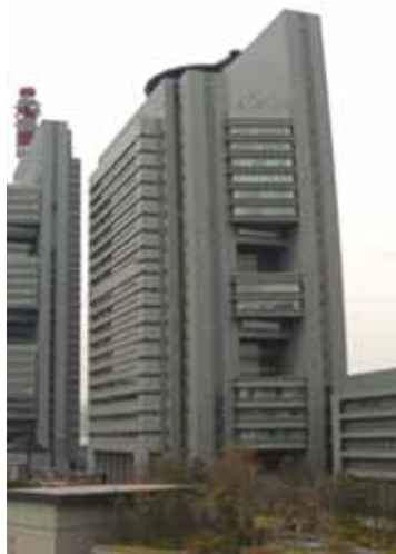
写真-1.5.4.1 さいたま新都心合同庁舎 2 号館
