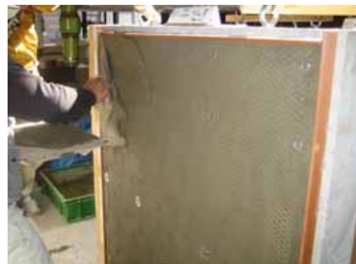
写真 1 耐久性と防耐火性を両立させた落下防止工法に関する試験施工の状況
