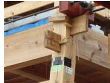
写真 2 実大静的加力試験 - 試験体 A 棟の柱折損
