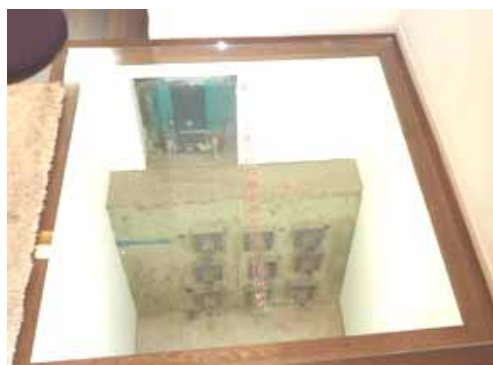
写真 - 1 UR団地内での施工例
