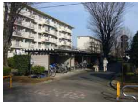
写真 2. 対象とする中層団地(同上)
