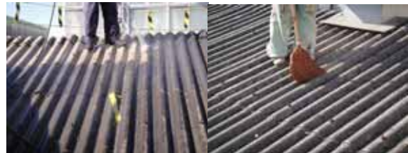
図1 下地調整の状況(左：高圧水洗、右：棕櫚箒)
