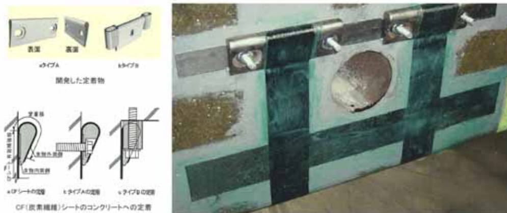
図 - 1 炭素繊維と鉄鋼プレートによるあと抜き開孔部の補強
