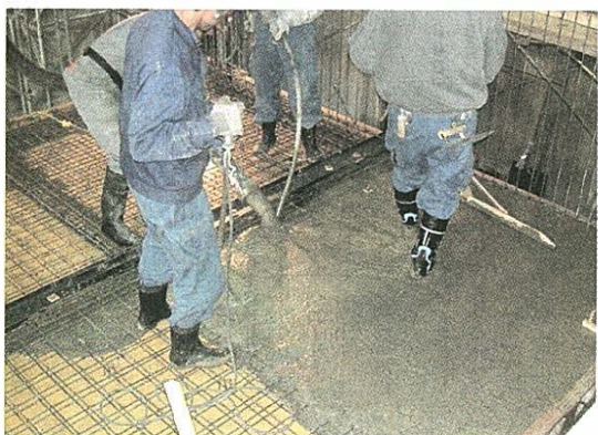
鉄筋を組んで型枠を付けコンクリートを流し込む
