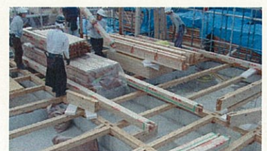
点検交換可能な床下空間
