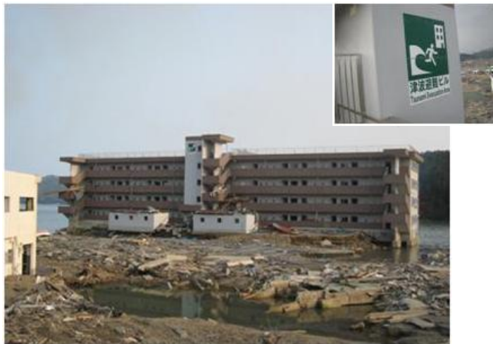
松原町営住宅(南三陸町) 30-40人が屋上に避難した
