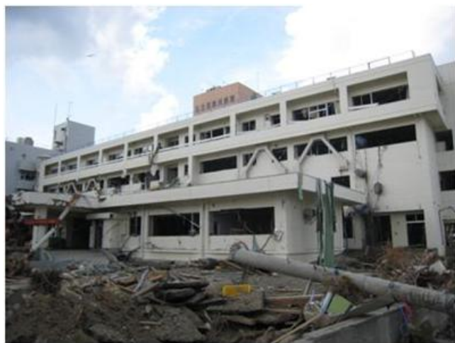
志津川病院(南三陸町) 約220人が屋上に避難した
