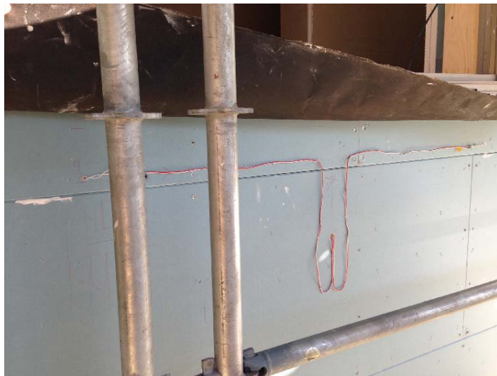
漏水センサ設置状況
