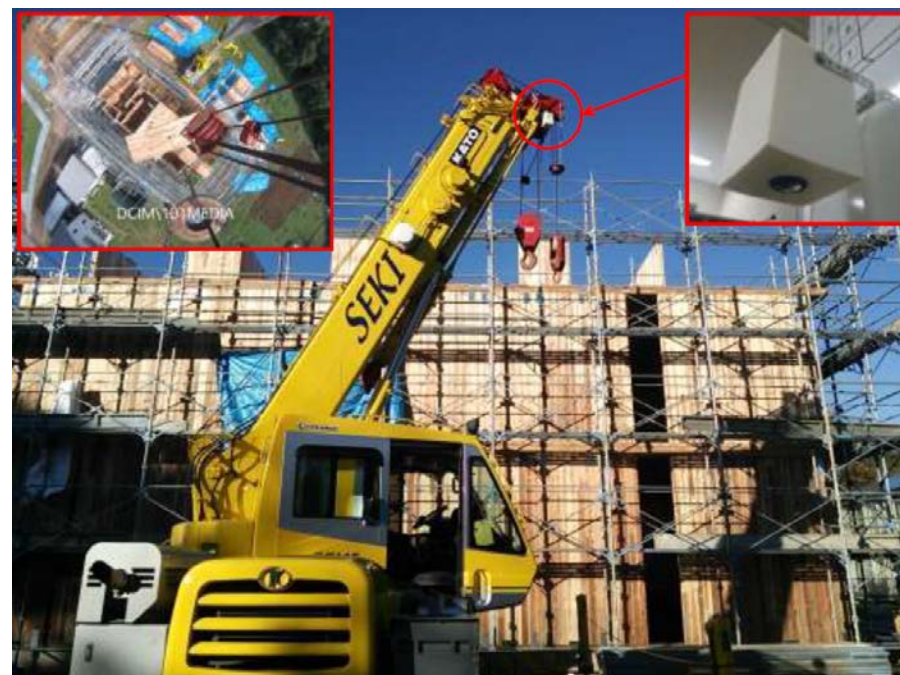
クレーンへのカメラ設置
