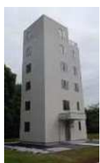
建築研究所に建設された木造6階建て耐火構造建築物(試験体)
