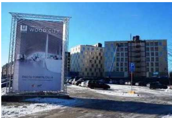
建設中の8階建共同住宅・事務所・ホテル (ヘルシンキ・フィンランド)
