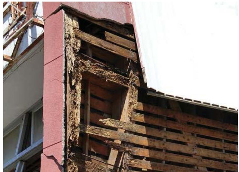
写真1 柱材の腐朽
