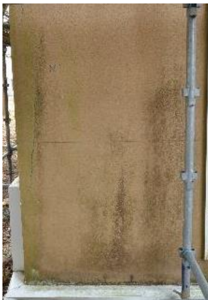
写真5.2 北東隅部北面モルタル外壁の現況
