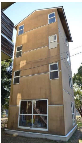
写真5.1 4階建て枠組壁工法実験棟
