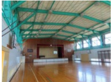
山形鋼ブレース体育館の内観
