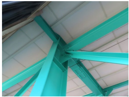
山形鋼ブレース接合部
