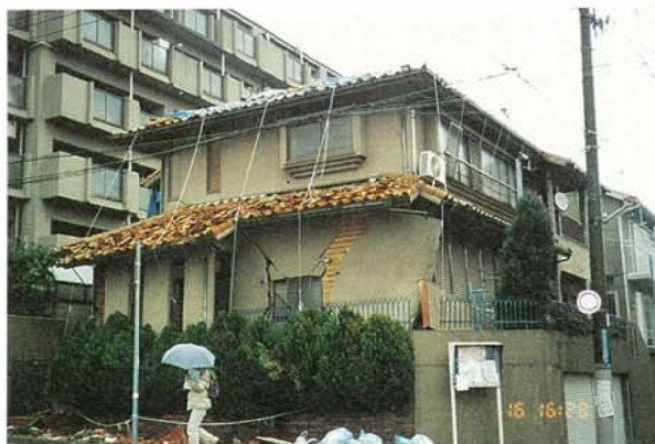
写真3.2.3.21 〔復旧事例、本山2〕 補修工事中の状況 (1995年3月)
