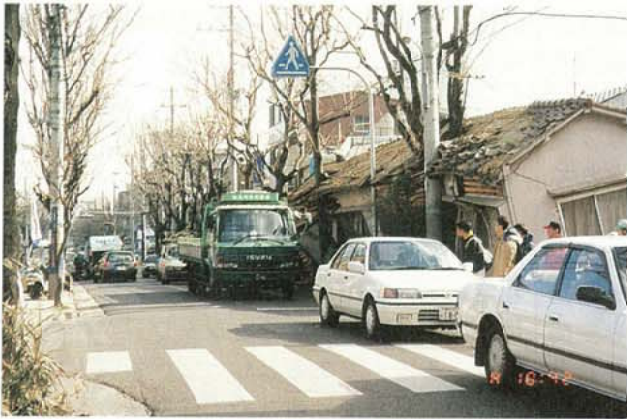
写真3.3.4.3 灘区岩屋北町2丁目 街路樹による家屋の倒壊防止事例
