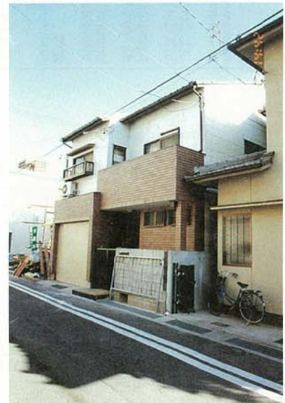
写真3.2.3.20 〔復旧事例、本山1〕 補修後の現在の状況 (1996年1月)
