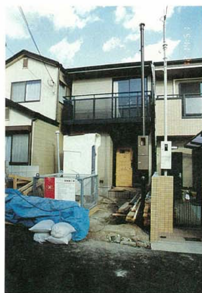
写真3.2.3.28 新築建物の連層壁（間口の狭い住宅への応用例）
