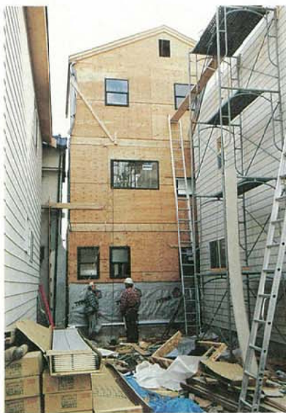
写真3.2.3.33 新築建物の耐力壁（枠組壁工法耐力壁へ合板を横張りした例）
