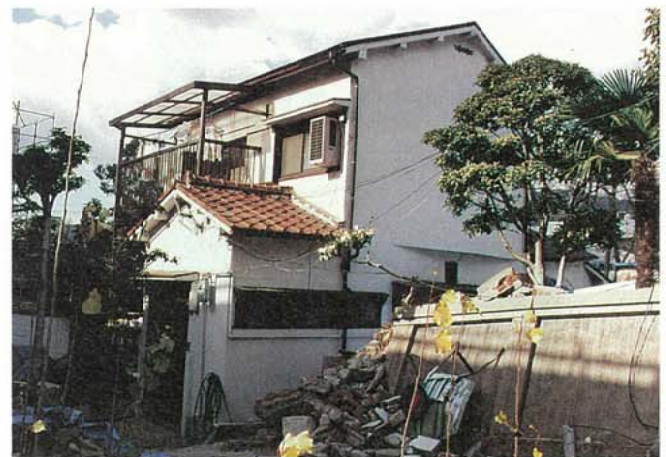
写真3.2.3.14 [復旧事例, 大石1] 復旧状況 (1996年1月)
