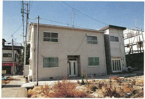
写真3.2.3. 8 [復旧事例、長田2] 補修による復旧状況
