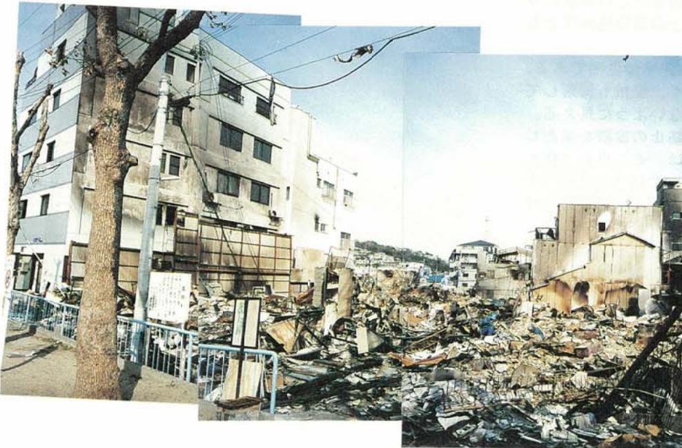
写真2：建築年代が比較的新しく、網入りガラスの入ったアルミサッシ窓を有する建物が焼け止まりとなる事例。ただし、RCの建物であっても、輻射熱のため、網入りガラスにひびが入っている事例。
