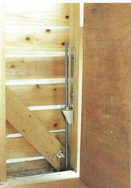
写真3.2.3.51 K動物病院 ホールダウン金物取り付け
