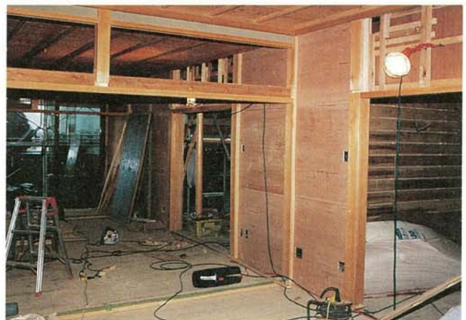
写真3.2.3.58 Y氏宅 内壁土塗り壁に真壁仕様で合板張り
