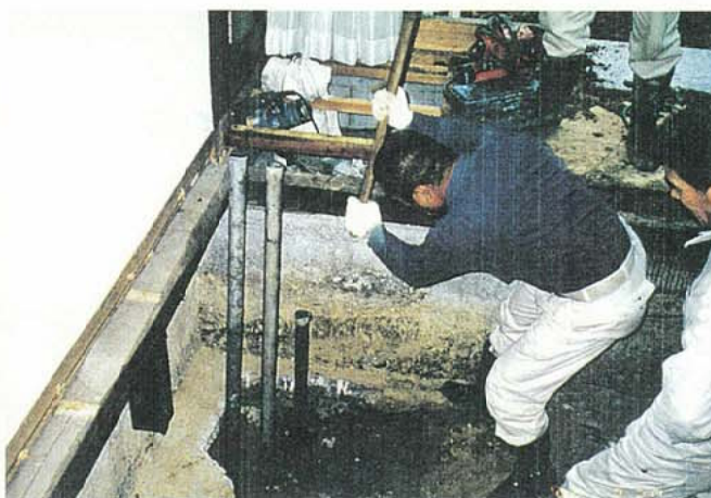
写真3.2.3.36 N氏宅 鋼管パイプ打ち込み
