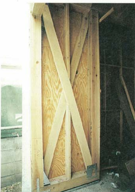
写真3.2.3.50 K動物病院 壁補強 (二つ割り筋違い構造用合板張り)
