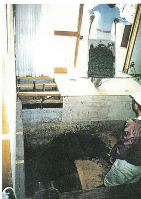
写真3.2.3.37 N氏宅 コンクリート打設
