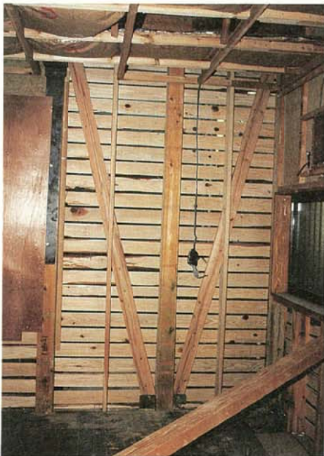
写真3.2.3.57 Y氏宅 東側外壁内側, 土塗り壁の撤去, 三つ割筋違いを二つ割筋違いに変更
