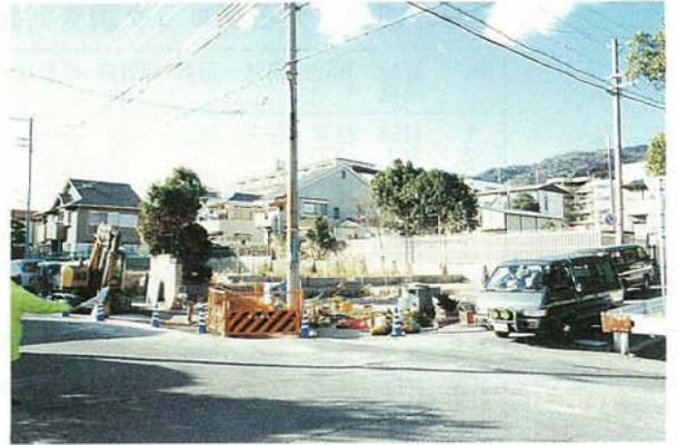
写真3.2.3.18 ブロックの復旧後の状況 (同左、1996年1月)
