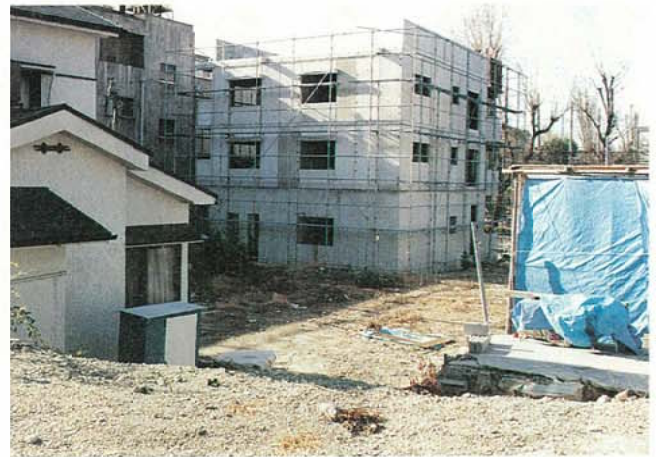
写真3.2.3.12 復旧状況 (同左, 1996年1月)
