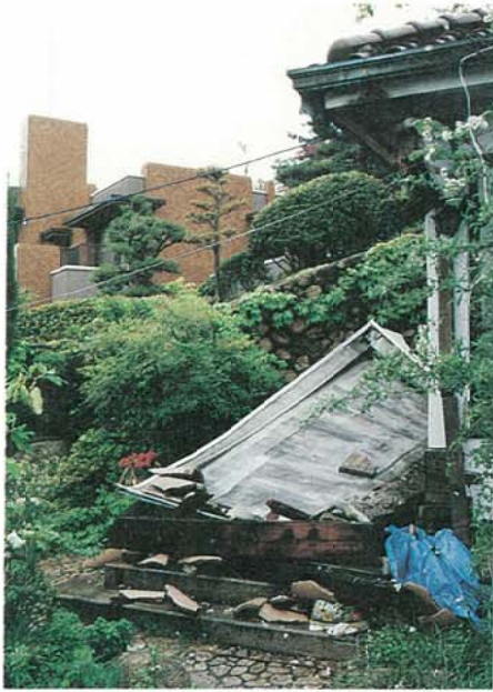
写真3.2.3.41 K氏宅 ポーチ被害状況
