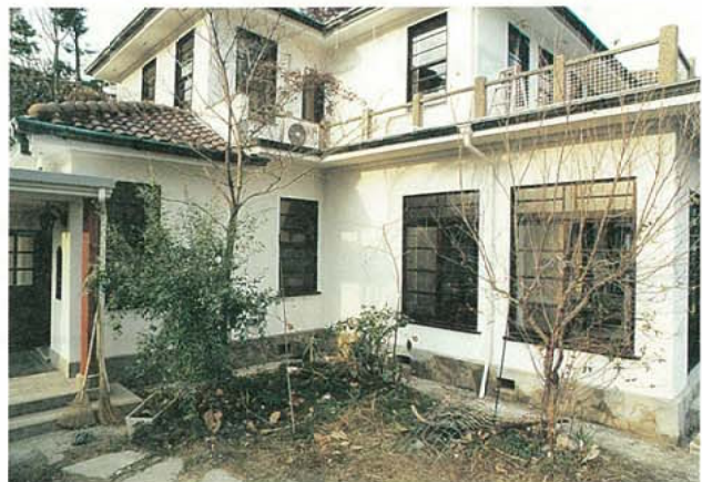
写真3.2.3.46 K氏宅 工事完了後全景
