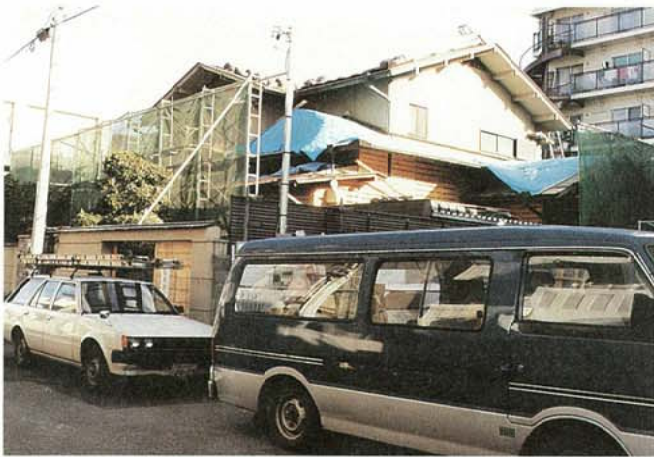
写真3.2.3.55 Y氏宅 復旧工事中
