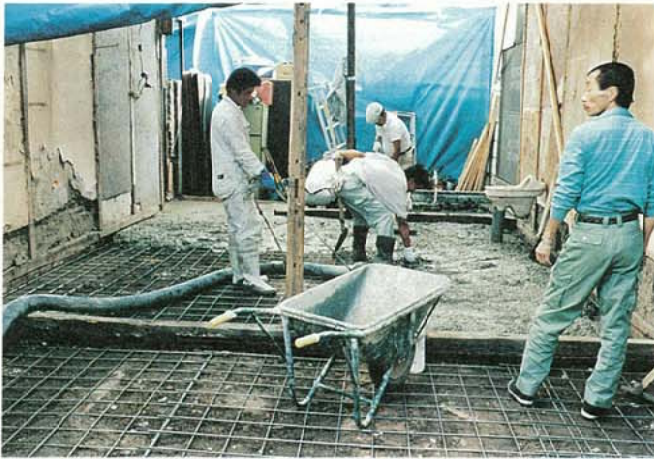
写真3.2.3.59 基礎部分のコンクリート打ち直し
