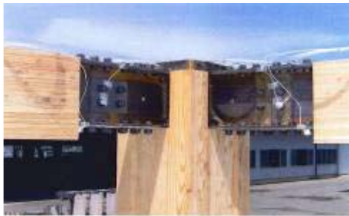
図 18 柱とはりの接合部（被覆前）
