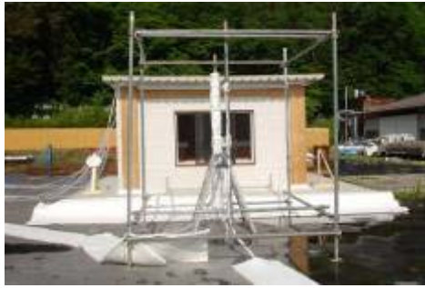
図 17 実験建物の外観
