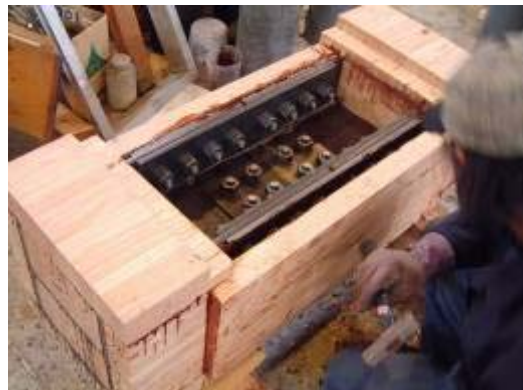
図 13 ボルト接合部分の耐火被覆
