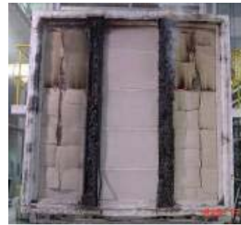
図16 耐火試験後の壁と柱の鳥合い部
