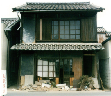
写真 17 柱脚が開いた被害例
