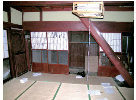
写真 19 柱脚移動に伴う被害例
