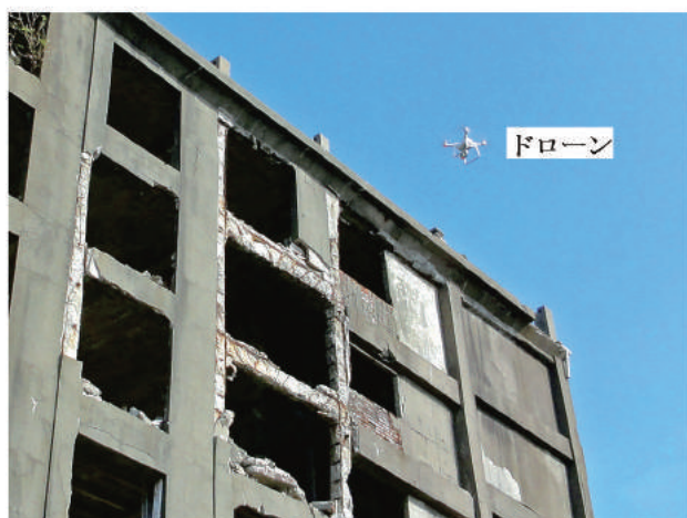
写真4 ドローンによる撮影状況(端島30号棟)
