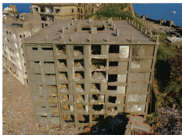
写真5 端島30号棟全景
