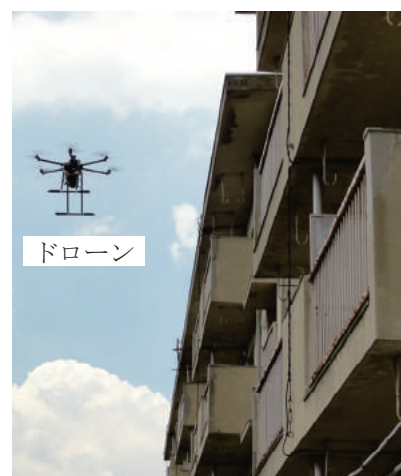
写真1 ドローンによる建物劣化調査
