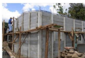
写真1 ブロックパネル造
