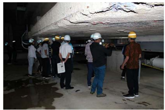
図19 耐震工学コース：国土地理院見学（免震ピット）（2019年10月）
