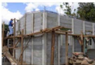
写真1 ブロックパネル造
