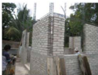
写真3 枠組積造（ソイルセメントレンガ）
