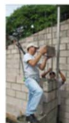
写真2 コンクリートブロック造
