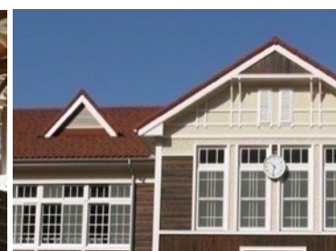
復活した小屋裏換気口
