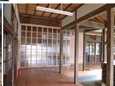
階段室の防寒間仕切り
