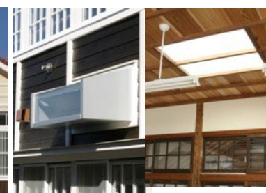
自然採光用光ダクト
