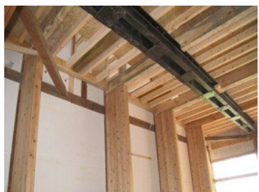
木造校舎耐震改修
