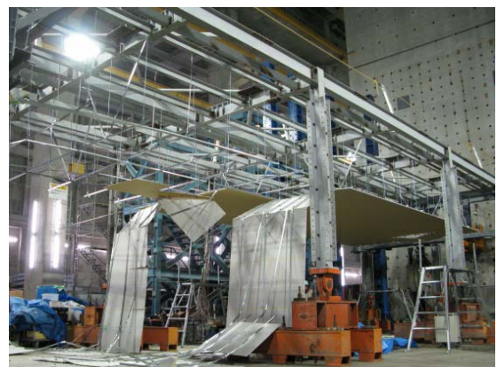
写真 3 クリップの外れによる天井面の落下 （大規模天井の加振実験）
