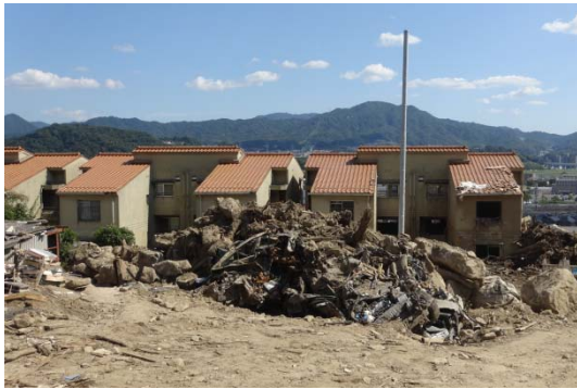
写真5 5号棟西側住戸全景
