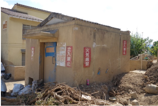
写真 19 プロパン庫の全景
