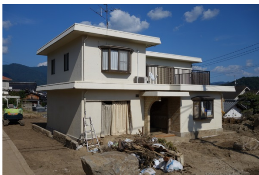
写真 26 コンクリートパネル造住宅
