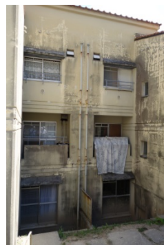
写真4 6号棟山側窓（目立った被害なし）
