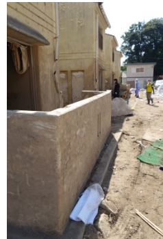
写真 18 9号棟山側の目隠し壁の状況
