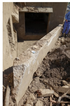
写真 16 道路側ドライエリアの擁壁
