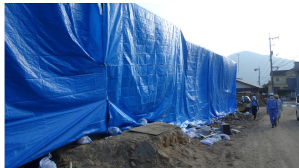
写真 33 木造 2 階建てアパートの山側
