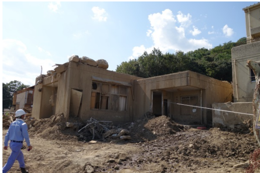
写真 13 集会所全景 (谷側より)
