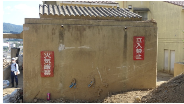
写真 20 プロパン庫の山側外壁
