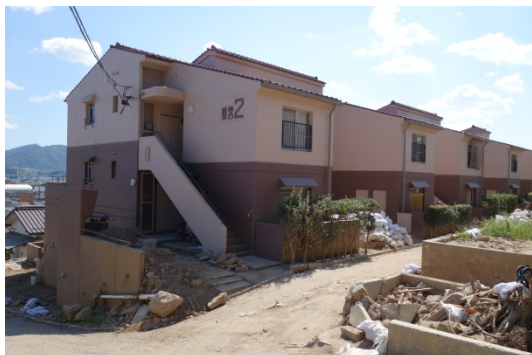
写真1 2号棟全景（目立った被害なし）
