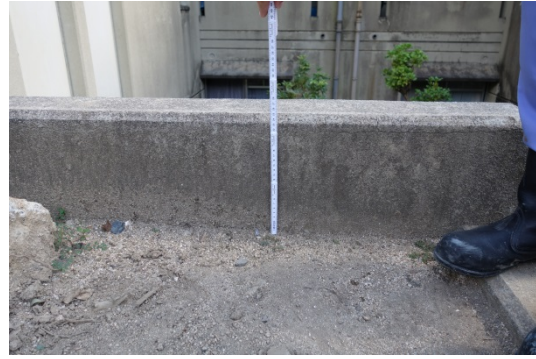
写真 12 RC 造壁高さ (無被害の別棟にて)
