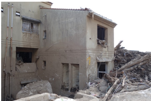
写真7 5号棟西端住戸の状況
