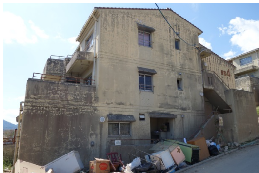
写真2 4号棟全景（目立った被害なし）
