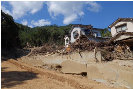
写真 23 川沿いで残存した木造家屋
