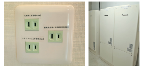
太陽光発電パネル(上)、住戸内の非常用コンセント(左下)、共用部の蓄電池(右下)
