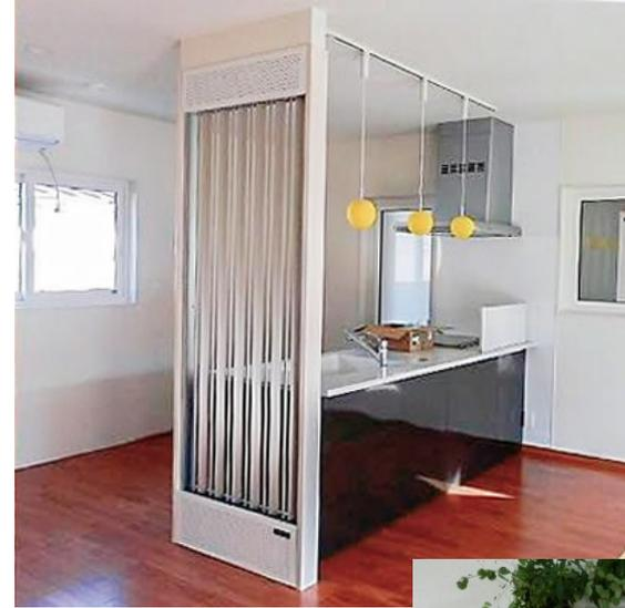
左:エアコン冷媒未利用熱方式の放射パネル設置例
