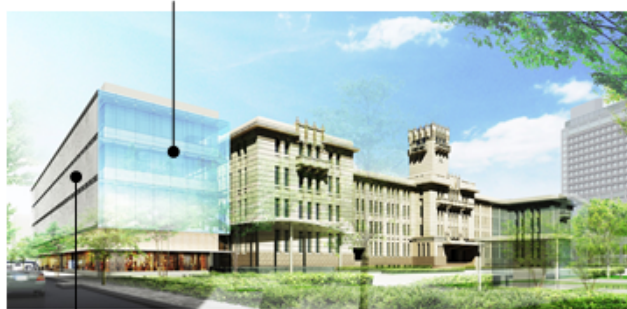
西庁舎西面：グレーチングルーバー
