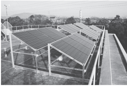
写真 1 太陽光発電装置 (定格 3 kw)
